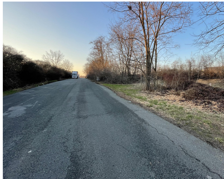
1. 2. 3. 4. Odstavné parkování směr Havlíčkův Brod
