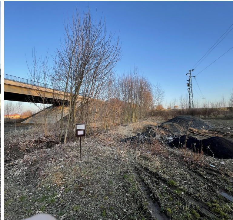
3. POHLED NA MOST A SILNICI I/38 SMĚREM NA ODSTAVNÉ PARKOVÁNÍ - PRAVÝ OKRAJ
