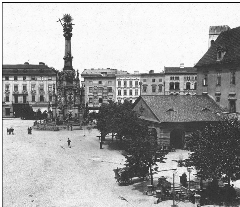
Obrázek č. 16: Horní náměstí a budova radnice s přistavěnou strážnicí u jižního průčelí na snímku z roku 1890
