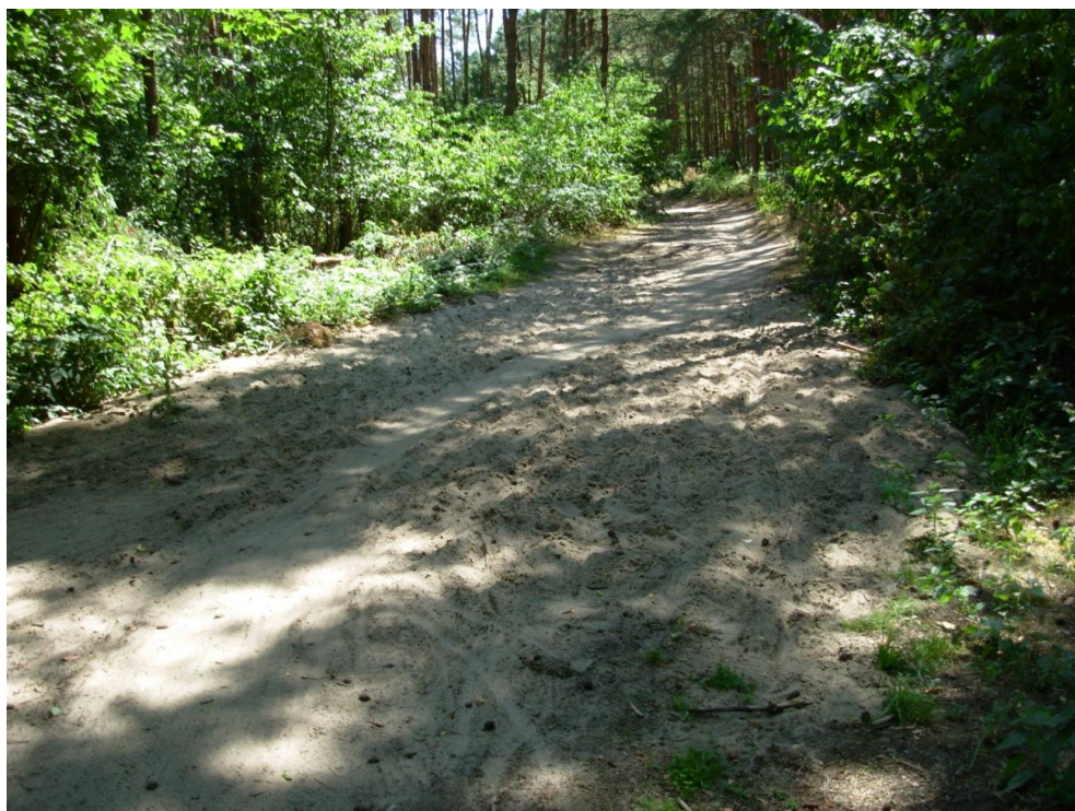
Obrázek 15 Eroze cyklotrasy, nebezpečný úsek s hlubokým pískem na trase Valtice-Lednice. Zdroj: vlastní foto, 26. 7. 2015
