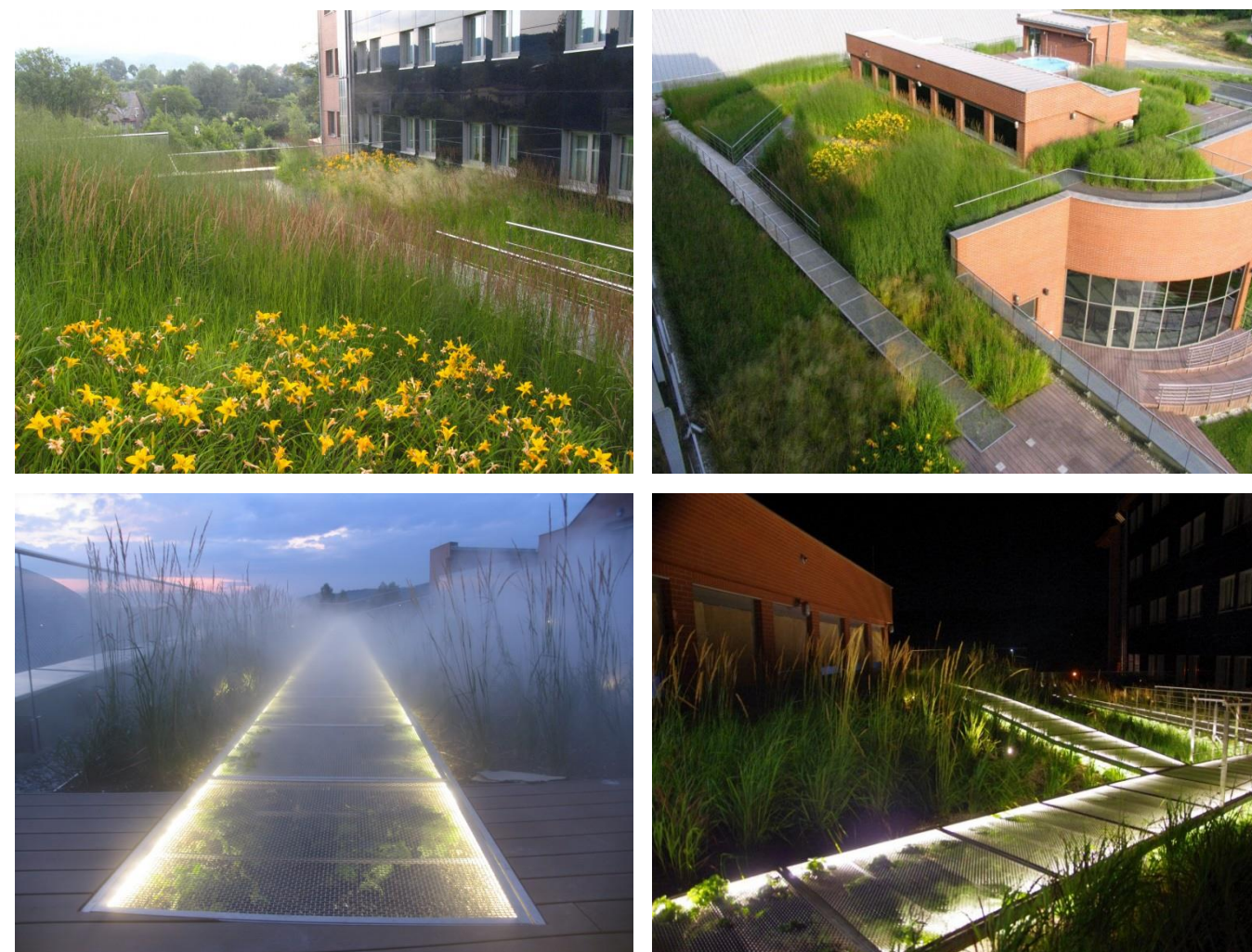
Obr. 50, 51, 52, 53 Střešní zahrada Tenis Hotel Vitality, a.s. - Vendryně
