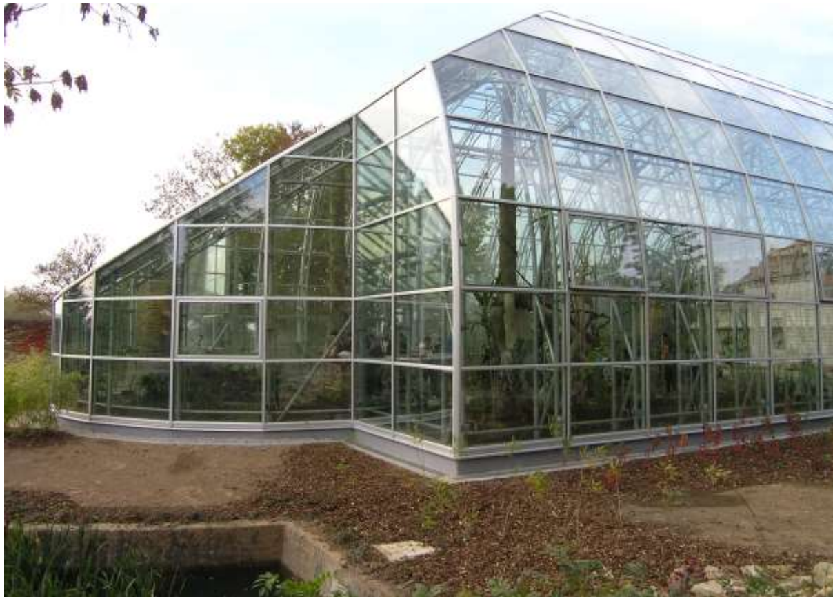
Tropický pavilon ZOO Lešná v době těsně po dokončení
