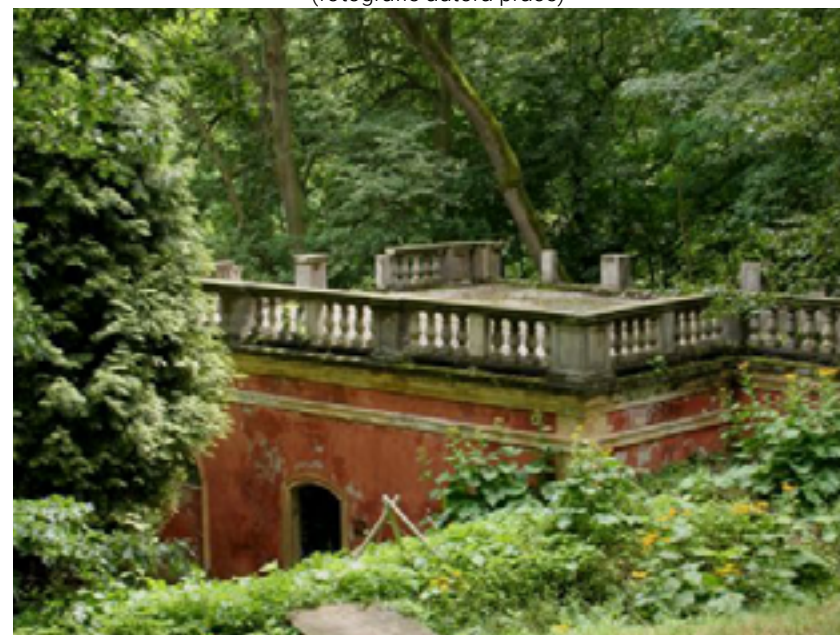
obr. 31 vodárna v Anglickém parku Dobříš (současný stav) (kamsevydat.cz)
