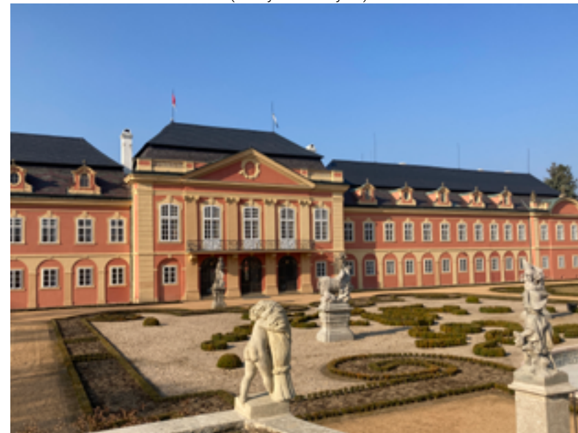
obr. 12 jižní pohled na dobříšský zámek (2022) (fotografie autora práce)
