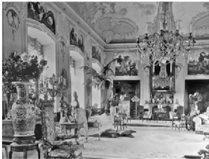
obr. 15 Zrcadlový sál dobříšského zámku (1908) (archiv zámku Dobříš)
