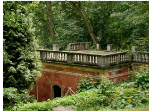
obr. 31 vodárna v Anglickém parku Dobříš (současný stav) (Jannevydídal.cz)
