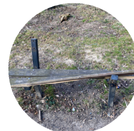
obr. 114 špatný stav mobiliářů
