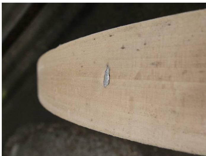
Ulpění kovového fragmentu pásnice ve dřevě
