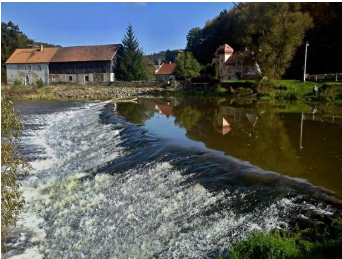
Obr. 17 Jez na začátku obce Podhradí nad Dyjí po dešti
