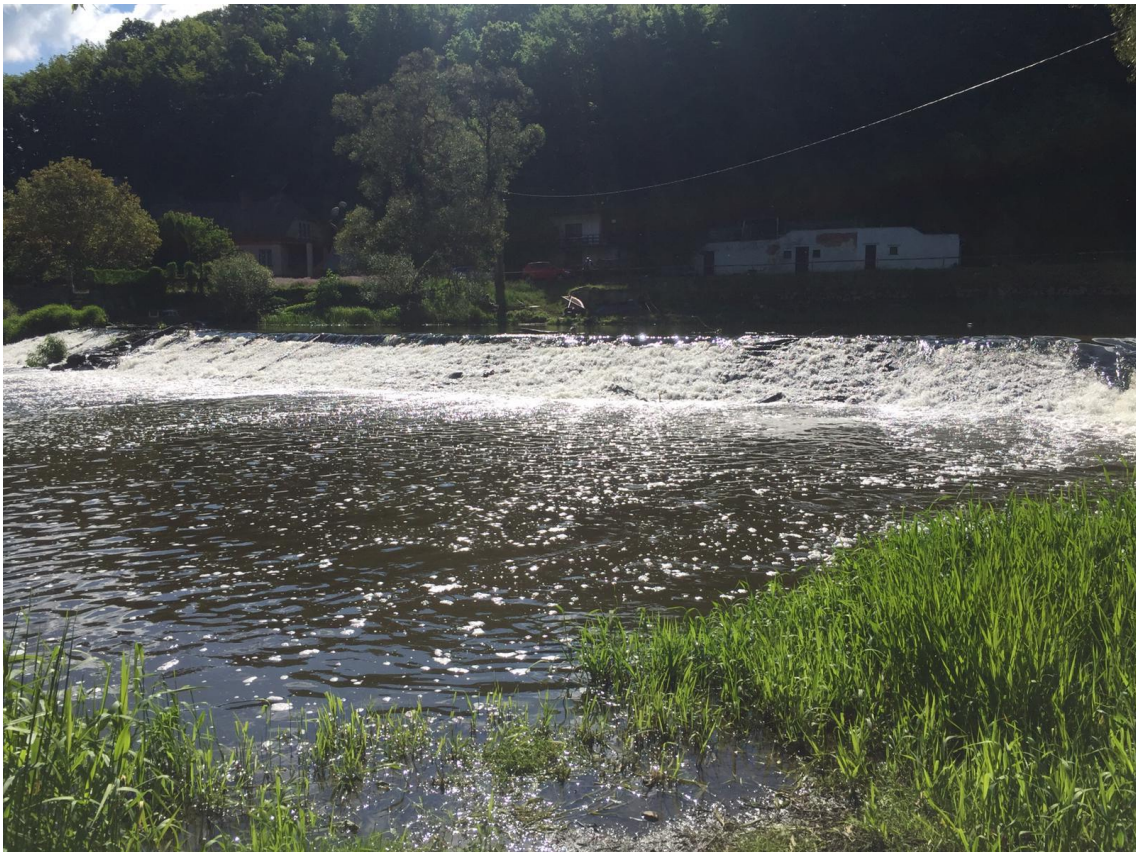
Obr. 19 Jez v Podhradí nad Dyjí po dešti
