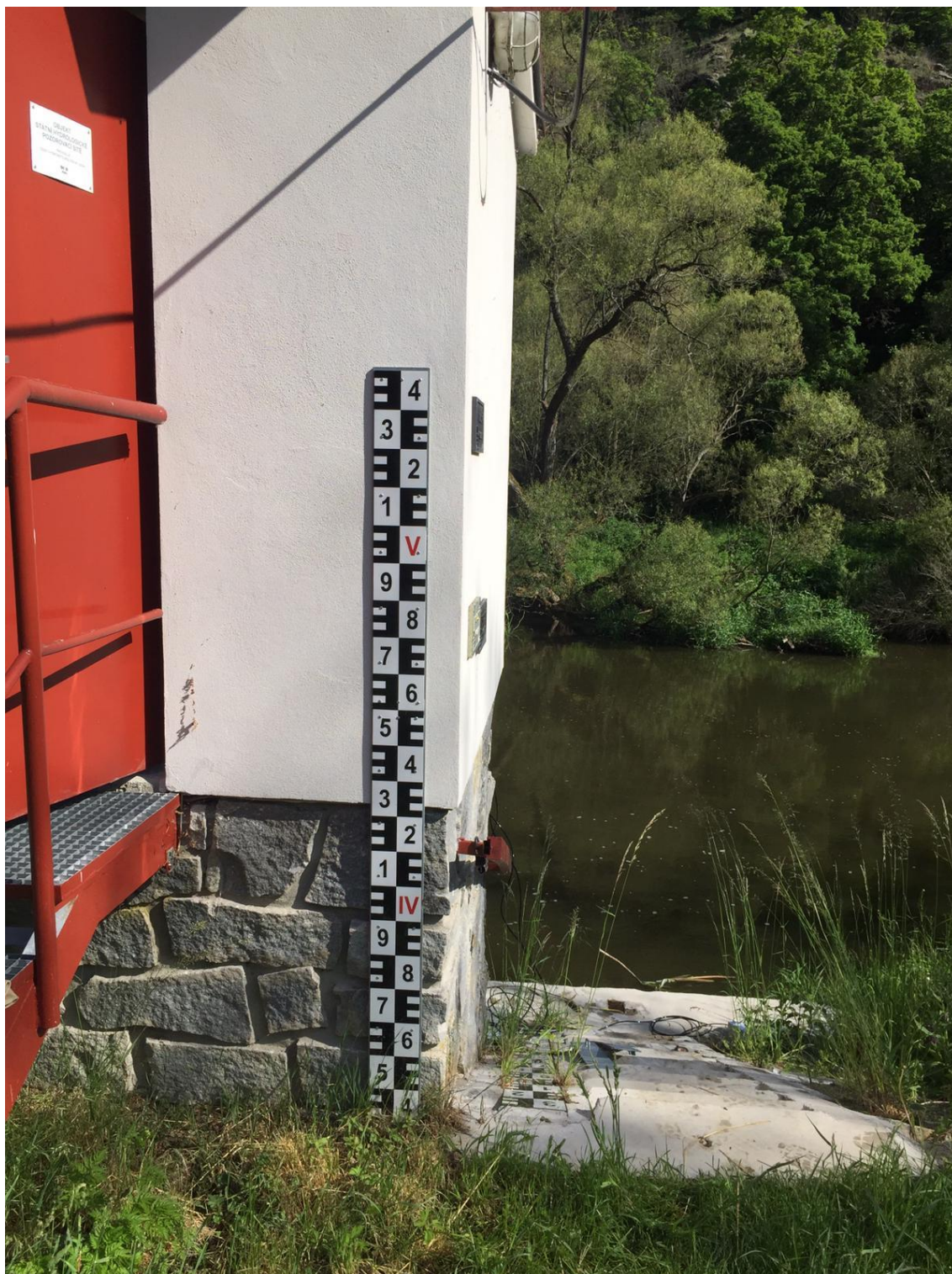
Obr. 21 Měření hladiny nad 4 metry výšky
