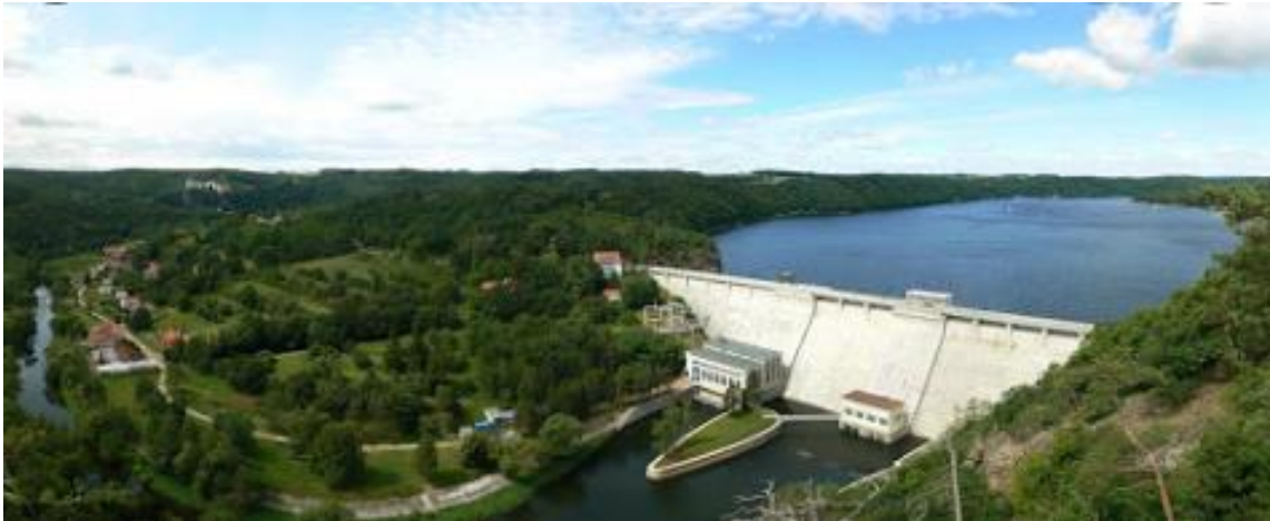
Obr. 28 Vodní hráz Vranov [19]
