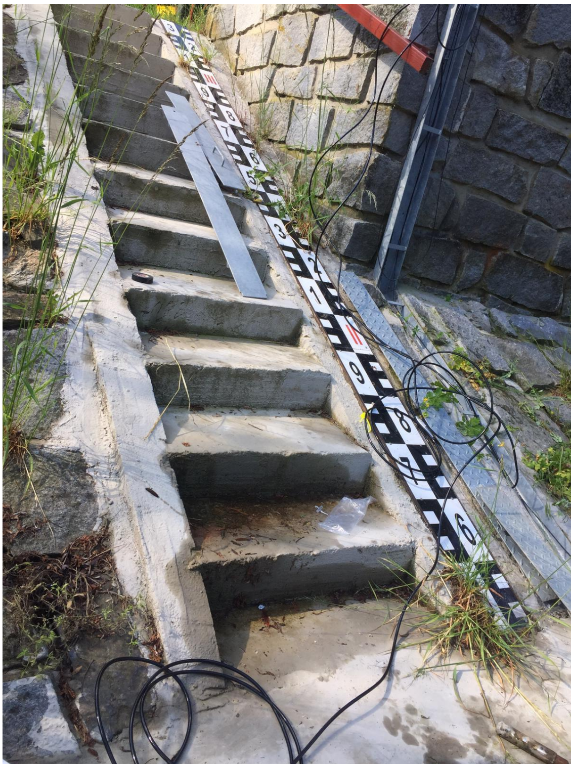
Obr. 23 Měření hladiny okolo 2–3 metrů výšky
