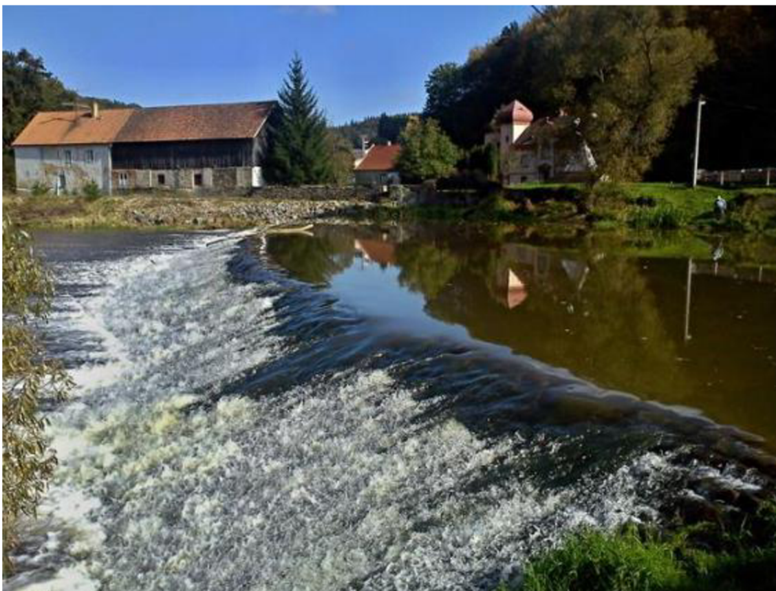
Obr. 17 Jez na začátku obce Podhradí nad Dyjí po dešti
