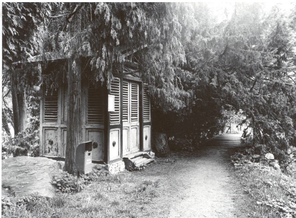
Obr. 18: Snímek převlékárny z jihu; Zdroj: Fotoarchiv GŘ NPÚ Praha, č. neg. 96238
