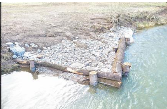
Obr. 82. Trojúhelníkový kmenový výhon vyplněný kameny, zeminou a zbytky dřevní hmoty (vpravo) (Regierungspräsidium Tübingen, 2018)
