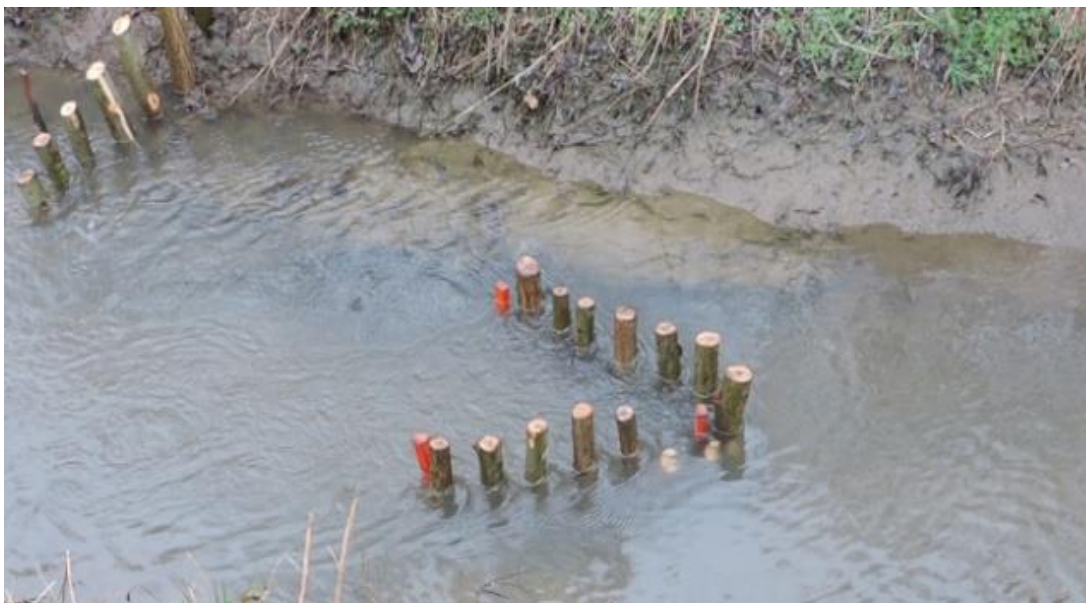
Obr. 175. Trojúhelníkový kůlový rozražeč uložený do proudnice z dřevěných kůlů (Salim, 2016)
