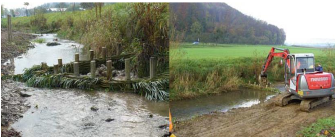
Obr. 76. – 77. Trojúhelníkový výhon z kůlů a vrbových prutů (vlevo), vysypán kamenivem (vpravo) (Jany, 2013)
