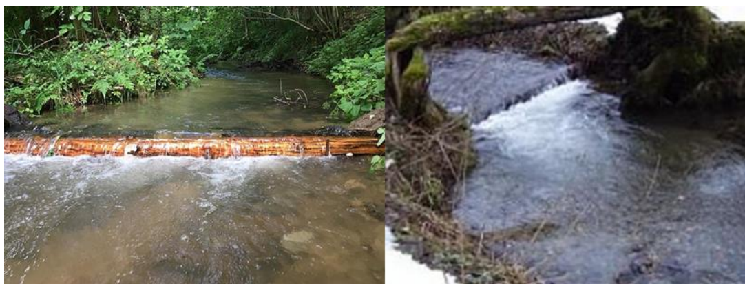
Obr. 177. – 178. Nízký kmenový stupeň s přijatelným rozdílem hladin (vlevo) a práh s ideálním rozdílem hladin (vpravo) (Knap, 2019)
