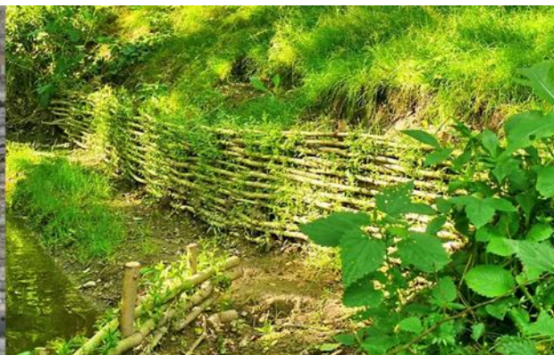
Obr. 96. Jednořadá výztuha břehu ze zápletkového plůtku (vpravo) (Jiránek, 2015)
