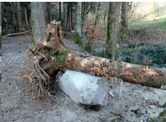
Obr. 147. Pařez s kotevním kamenem před vložením do toku (vpravo) (Hartmann, 2018)
