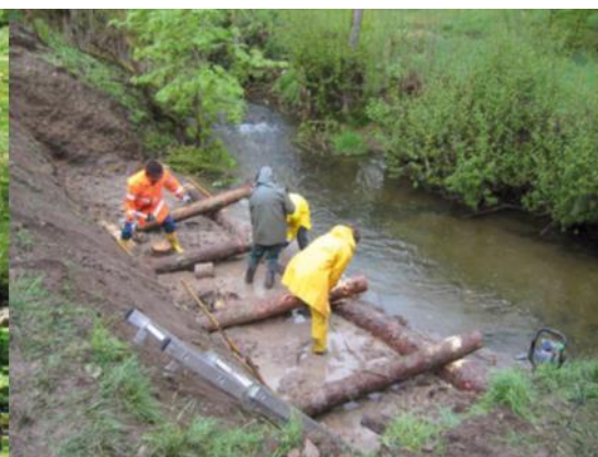
Obr. 143. Stavební úpravy kmenové stavby (vpravo) (Jany, 2013)
