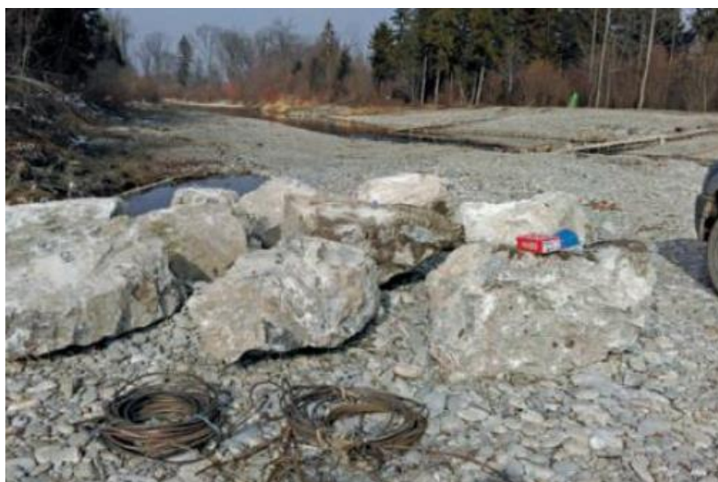
Obr. 12. Velké kameny a ocelová lana připravena k jištění dřevních prvků (Hausammann., 2018)
