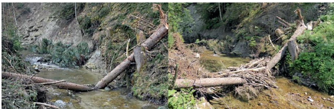
Obr. 189. – 190. Kmenový lapač po instalaci v prosinci 2016 (vlevo) a v červnu 2017 (vpravo) (Meier, 2018)
