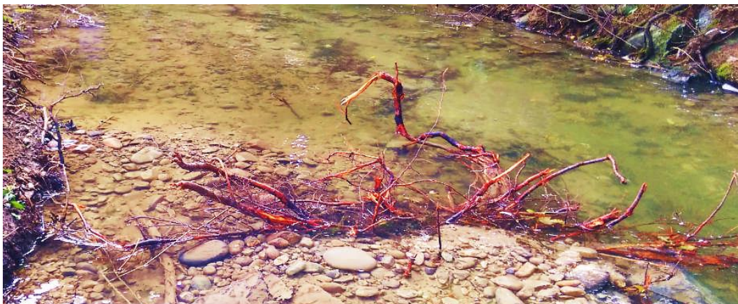
Obr. 152. Pařez umístěný ve dně, celý kmen je nutné zapravit tak, aby vyčníval pouze kořenový bal (Tent, 2016)
