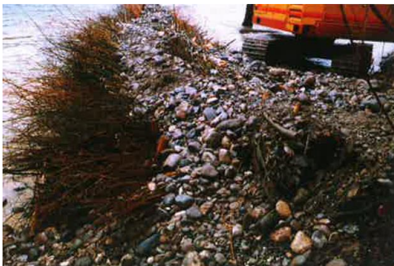
Obr. 70. Trojúhelníkový víceřadý haňoštěrkový výhon vyplněný kameny, zeminou a zbytky dřevní hmoty (Gebler, 2005)
