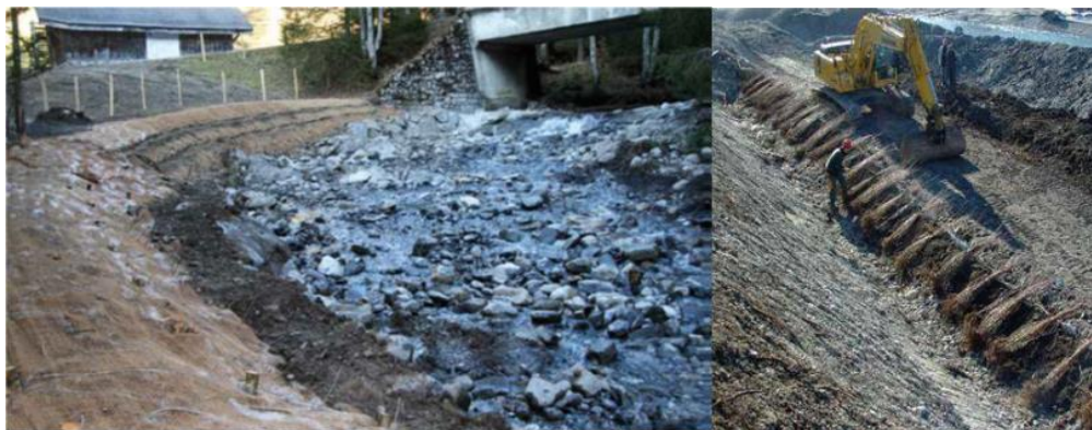
Obr. 123. – 124. Průběh výstavby břehového opevnění (Bonin, 2013)
