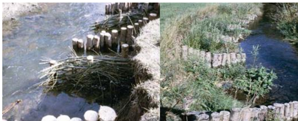
Obr. 133. - 134. Zápleťový plůtek (vlevo) a stejný tok v prvním vegetačním období (vpravo) (Jany, 2013)
