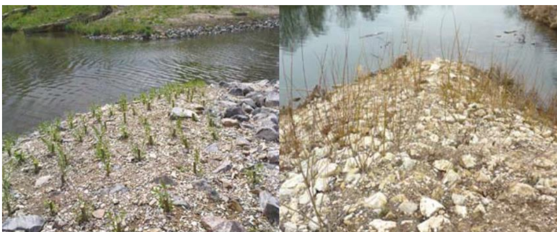
Obr. 84. – 85. Napučené vrbové kůly první rok po osazení (vlevo) a vegetace během první zimy (vpravo) (Jany, 2013)
