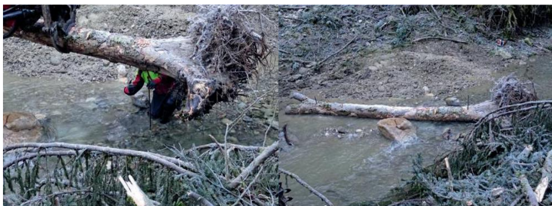
Obr. 13. – 14. Ukotvení kmenů pomocí závitových tyčí k podloží (Meier, 2018)
