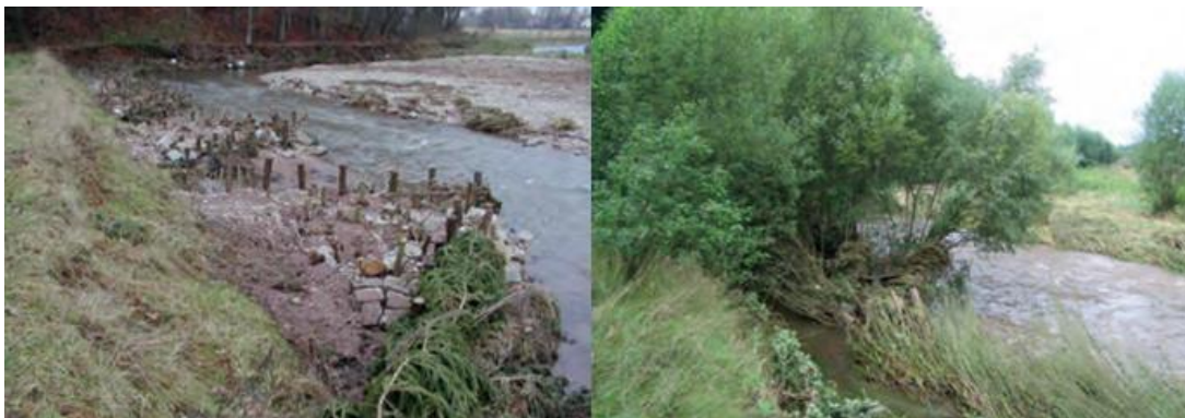
Obr. 74. – 75. Trojúhelníkový výhon, u nárazového břehu upevněn celý strom (vlevo) a stav toku 6 let po provedení opatření (vpravo) (DBVU, 2020)
