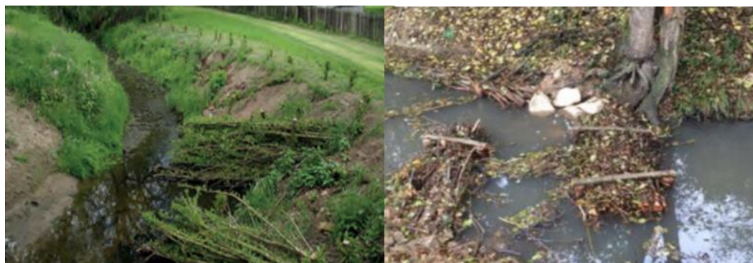
Obr. 63. Usměrňovače z vrbových válců (vlevo) (TLUG, 2015)
