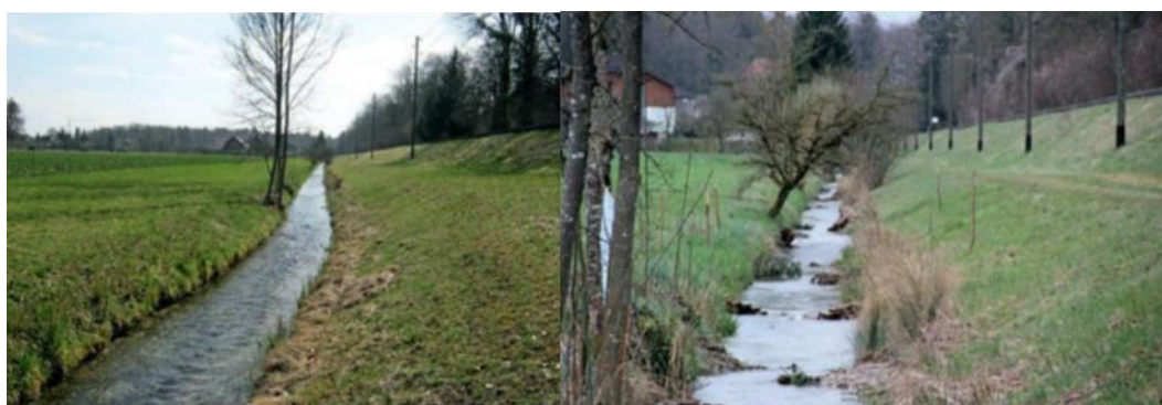
Obr. 20. – 21. Narovnaný úsek toku (vlevo) a tentýž úsek po vložení dřevních prvků (vpravo) (Hartmann, 2018)
