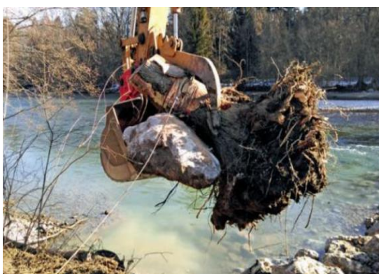
Obr. 150. – 151. Vlevo fotografie objektu při instalaci do toku a vpravo již umístěné pařezy v menším toku (Hartmann, 2018)
