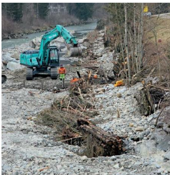
Obr. 93. Ukládání dřevních struktur z větví a kmínků do břehů koryta (Hartmann, 2018)
