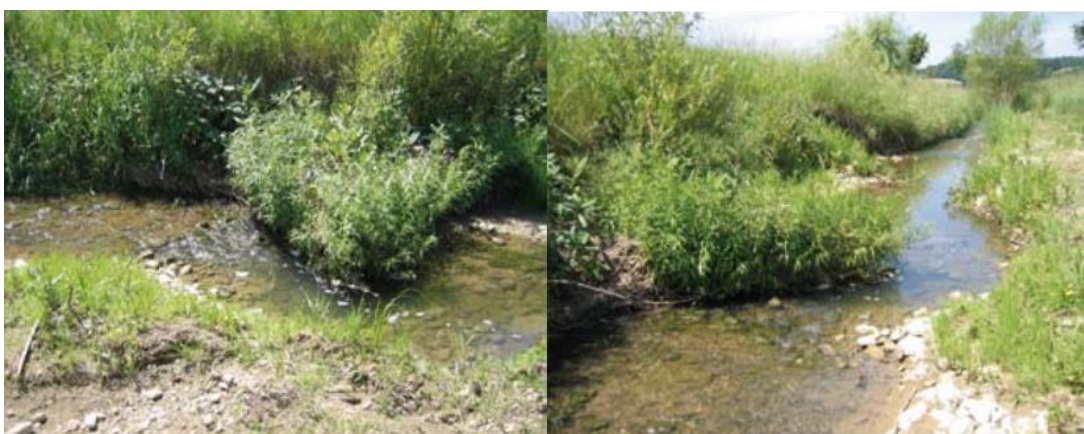
Obr. 78. – 79. Trojúhelníkový výhon z kůlů a vrbových prutů jeden rok po instalaci (vlevo i vpravo) (Jany, 2013)
