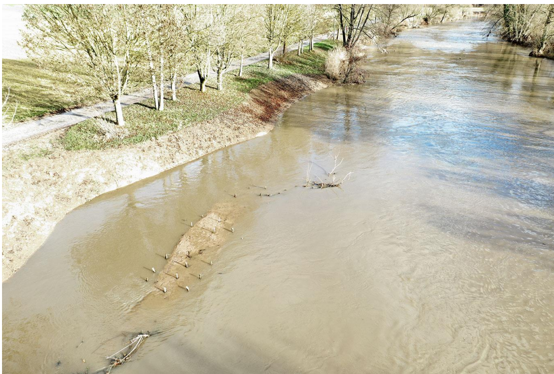
Obr. 7. Řízky z vrbového materiálu v mělkém úseku toku (Regierungspräsidium Tübingen, 2018)
