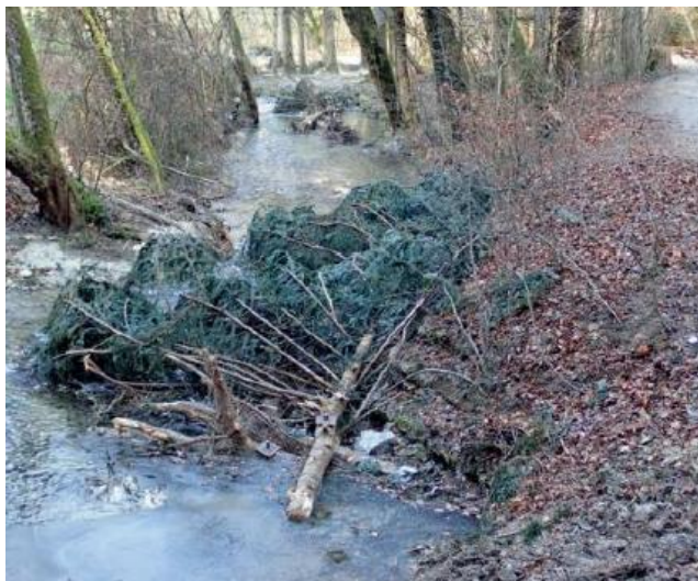
Obr. 90. Pokácený strom upevněný podél břehu (Hausammann, 2018)
