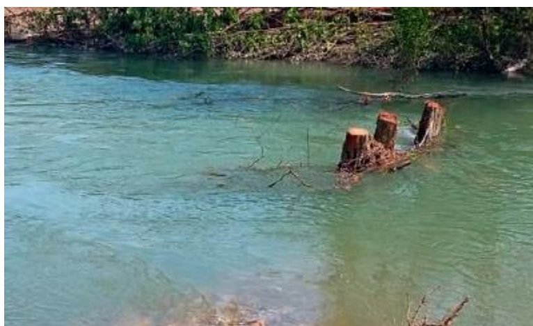
Obr. 182. Tři kmenové kůly slouží zároveň jako rozražeče proudu i jako lapače plavenin (Werdenberg, 2018)
