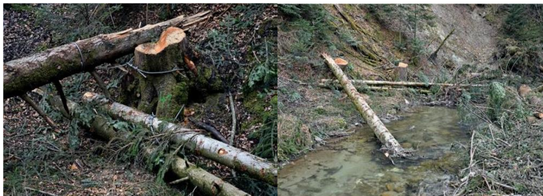
Obr. 38. – 39. Ukotvení kmene padlého stromu k pařezu ocelovými lany (Meier, 2018)
