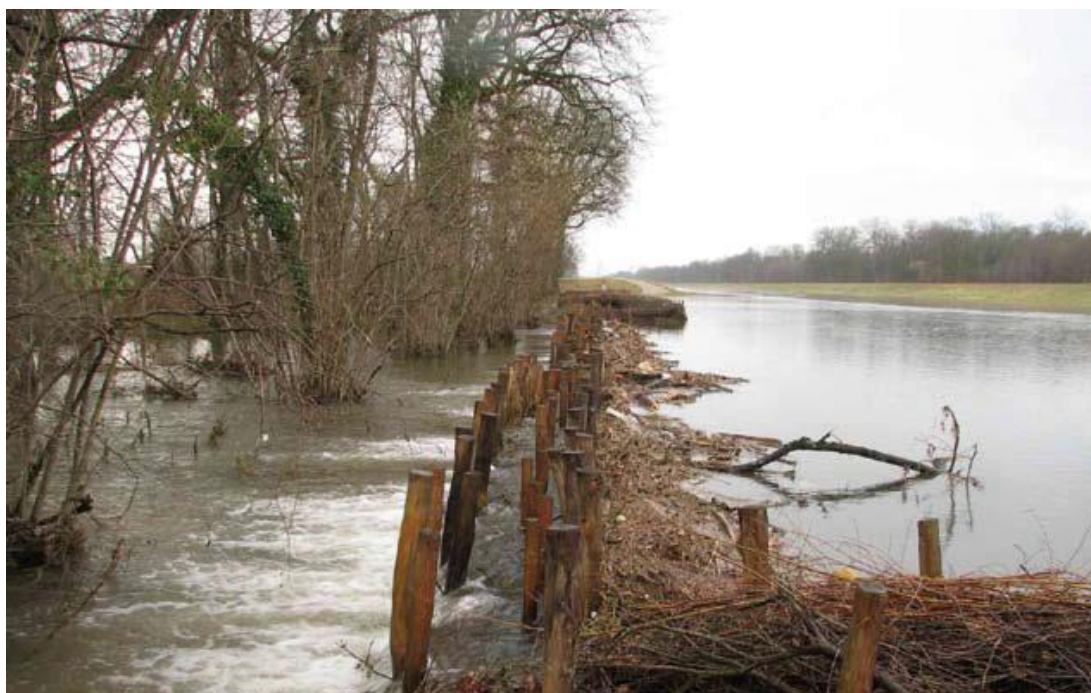
Obr. 187. Zanášející se hrabla při povodni (Jany, 2013)
