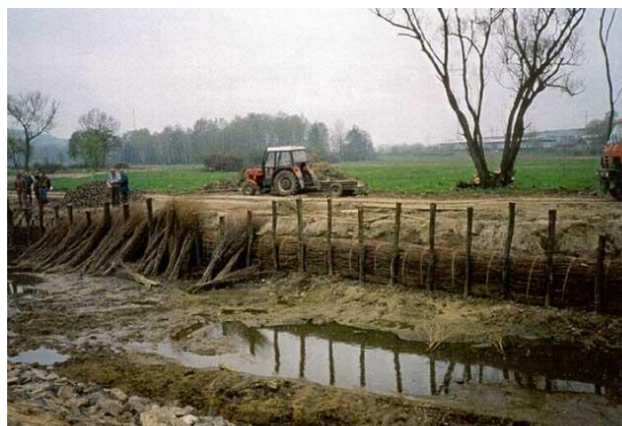
Obr. 111. Instalace haťošterkových válců (Sklenář, 2013)
