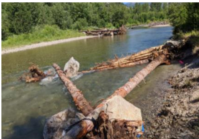
Obr. 5. Základ konstrukce stavby z kmenů mrtvého dřeva pro revitalizaci řeky ((NSD, 2019)
