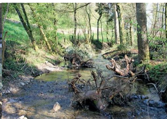
Obr. 150. – 151. Vlevo fotografie objektu při instalaci do toku a vpravo již umístěné pařezy v menším toku (Hartmann, 2018)
