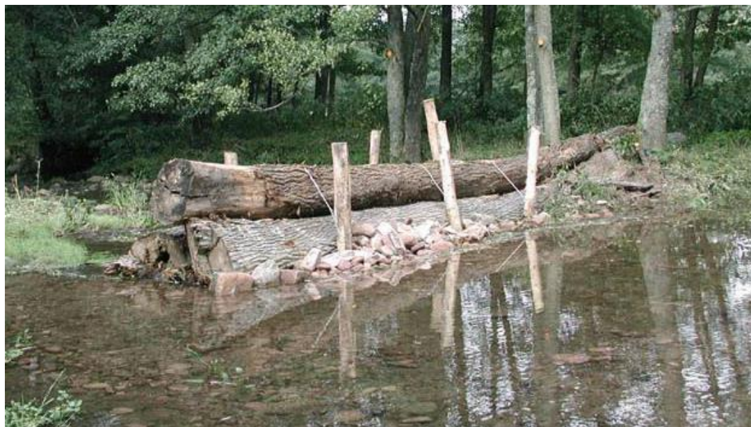
Obr. 33. Kmenová pyramida na toku zajištěná dřevěnými kůly a lany, na břehu je umístěna mezi dva vzrostlé stromy (Gebler, 2005)
