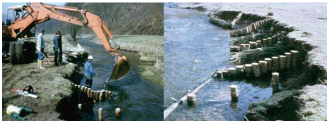
Obr. 131. – 132. Výstavba břehových hřebenů z kůlů (vlevo) v kombinaci se zápletovými plůtky (vpravo) (Jany, 2013)
