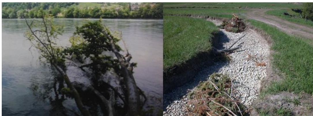
Obr. 54. Větve upevněné ze břehu do koryta toku (Gebler, 2005)
