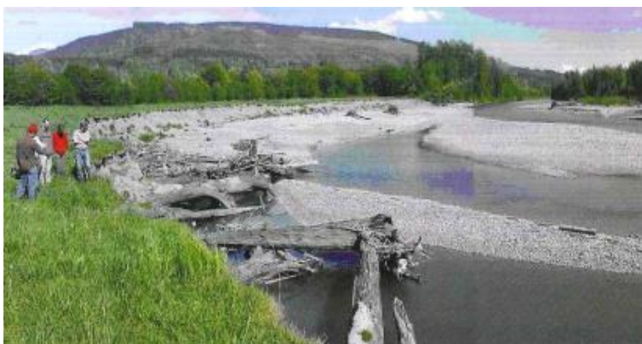
Obr. 50. Dříky stromů integrované do břehu (Abbe T., 2009)
