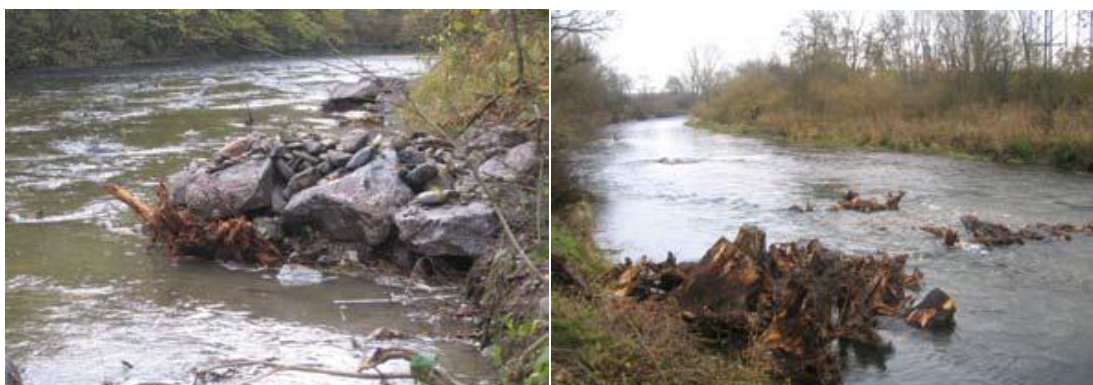
Obr. 163. – 164. Pařez uložený kořeny vzhůru a zajištěný kameny (vlevo), pařezový výhon a ostrůvky (vpravo) (Jany, 2013)
