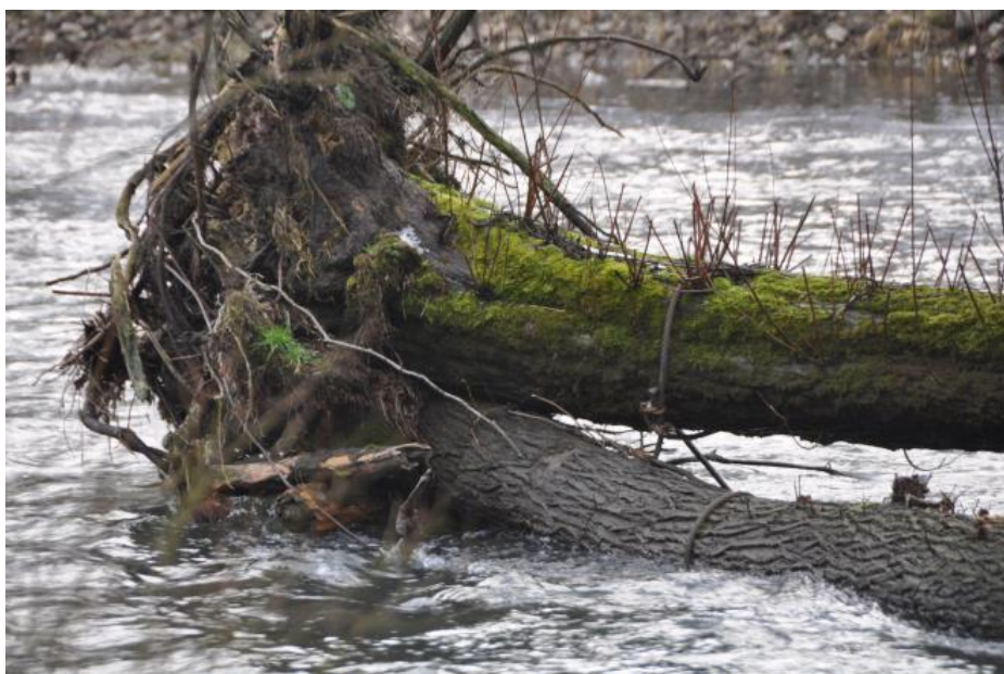
Obr. 49. Vyvrácené stromy upevněné svázané ocelovými lany (GFG, 2009)
