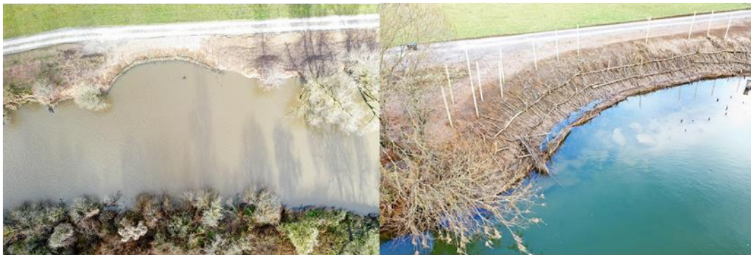
Obr. 104. – 105. Vrbové fašiny a pruty k obnovení břehové vegetace (Regierungspräsidium Tübingen, 2018)
