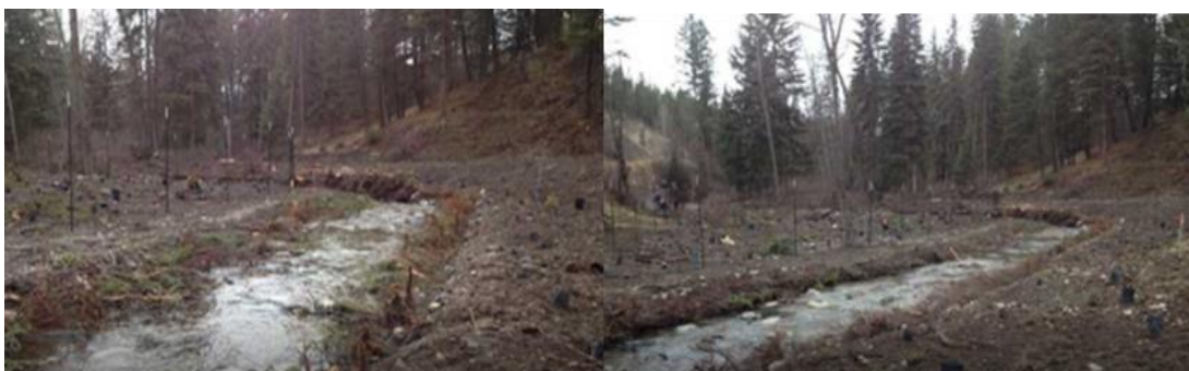
Obr. 115. -116. Drobné větve a proutí v březích (vlevo) a protierozní ochrana břehu (vpravo) (KRN, 2013)
