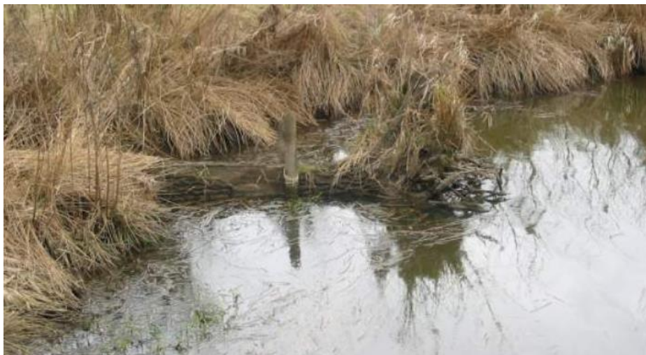
Obr. 48. Vyvrácený strom upevněný dřikem do břehu a kořenovou deskou do proudnice (GFG, 2009)
