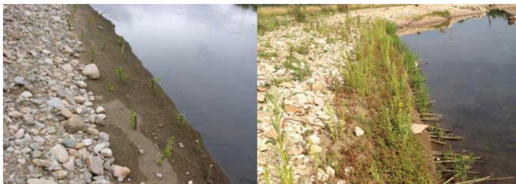
Obr. 128. – 129. Zpevnění břehu geotextilií a vrbovými kůly (vlevo), napučená vegetace v prvním vegetačním období (Jany, 2013)
