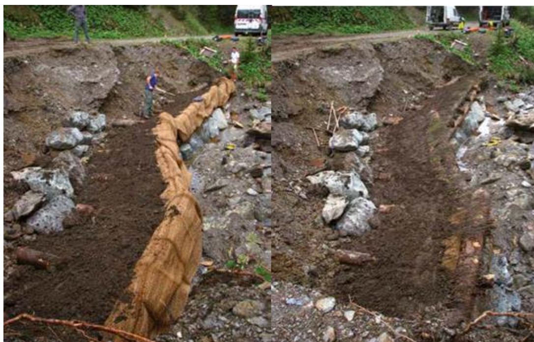
Obr. 140. – 141. Naplnění konstrukce ornicí (vlevo) a uložení kmenů (vpravo) (Bonin, 2013)
