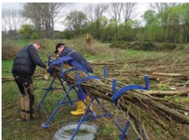
Obr. 68. Výroba haťového válce (Stowasserplan GmbH, 2018)
