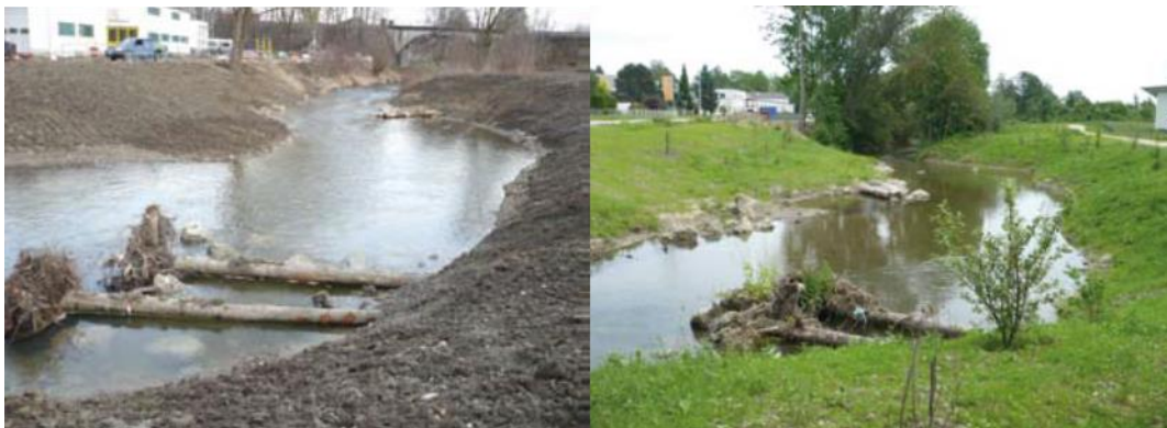
Obr. 44. – 45. Revitalizovaný úsek toku pomocí kmenů s kořenovým balem (vlevo) a tentýž úsek 3 měsíce po dokončení úprav (vpravo) (Jany, 2013)
