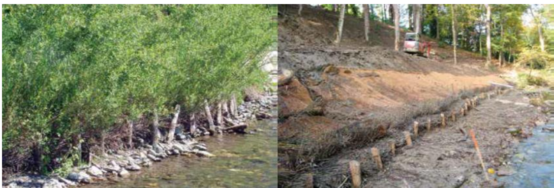
Obr. 119. – 120. Biologická protierozní ochrana břehů pomocí vrbového proutí (Bonin, 2013)
