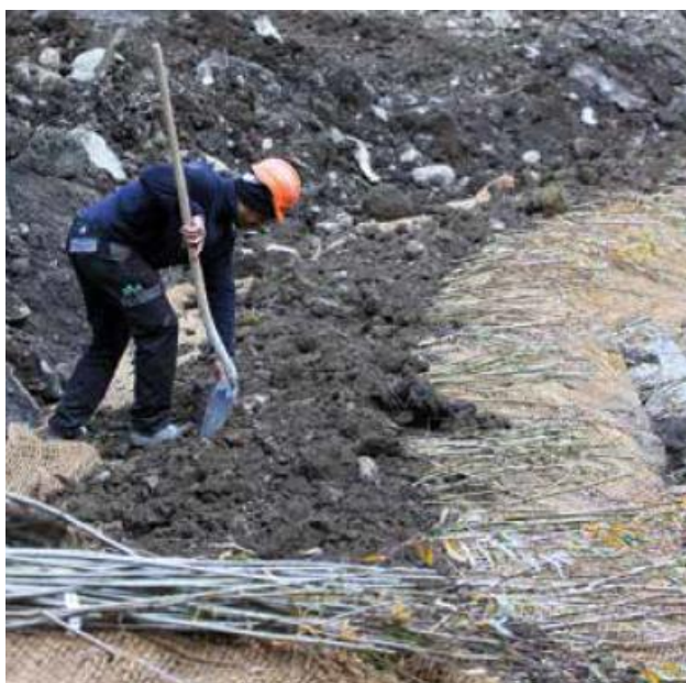
Obr. 103. Osazování vrbových prutů do upraveného břehu s geotextilií (Bonin, 2013)
