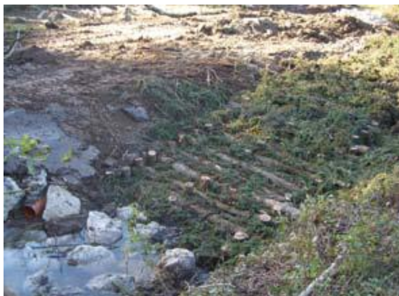
Obr. 195. Skluz z kulatiny po vybudování zabezpečený kůly (Jany, 2013)
