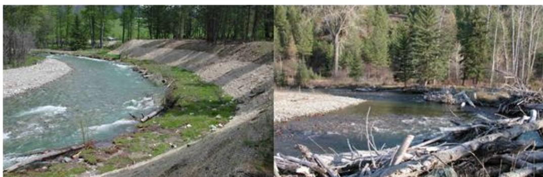
Obr. 91. – 92. Ochrana břehů uloženými samostatnými kmeny (vlevo) nebo celými svazky kmenů a větví (vpravo) (KRN, 2001)
