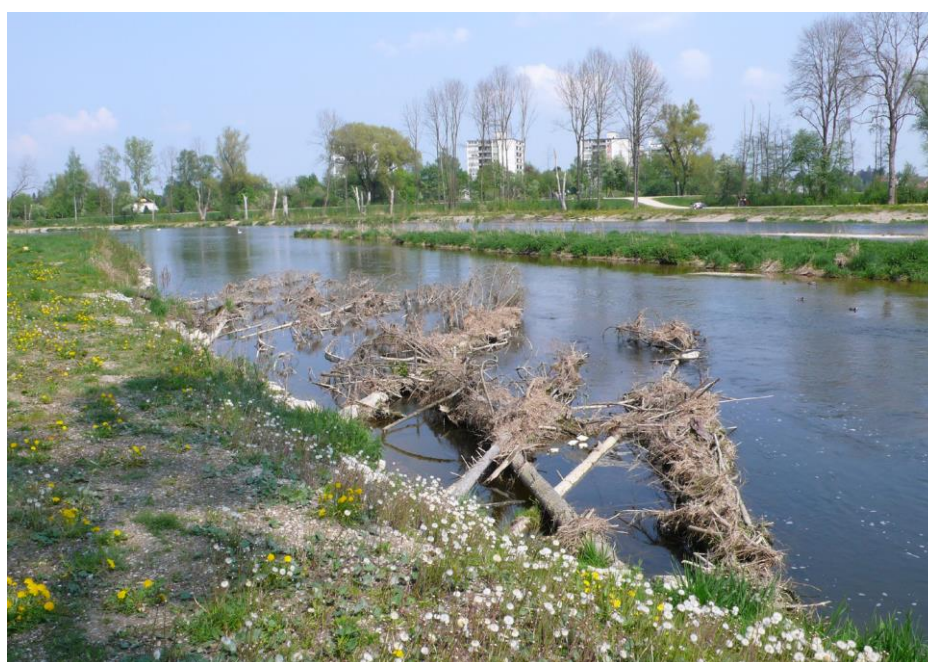
Obr. 42. Smrky upevněné spodní částí stromu do břehu řeky (Just, 2016)
