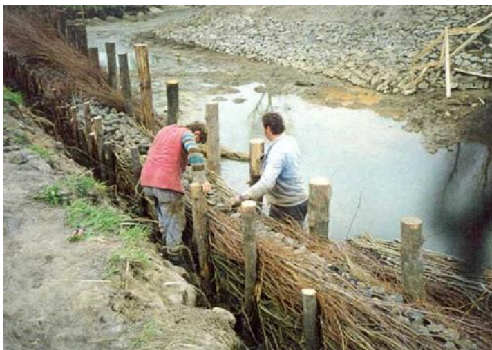
Obr. 110. Výroba haťošterkových válců v terénu (Sklenář, 2013)
