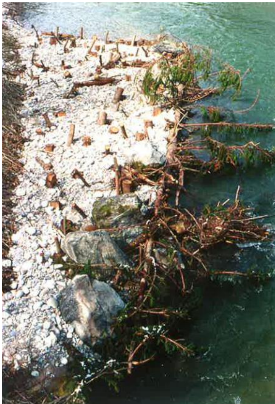
Obr. 73. Trojúhelníkový hačošťerkový výhon vyplněný kameny, ochrana náplavové strany je podpořena padlým stromem (Gebler, 2005)
