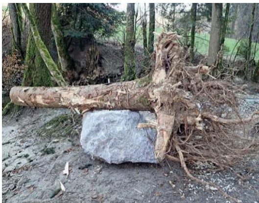
Obr. 146. Pařez s kotevním kamenem před vložením do koryta (vlevo) (Haussammann, 2018)
