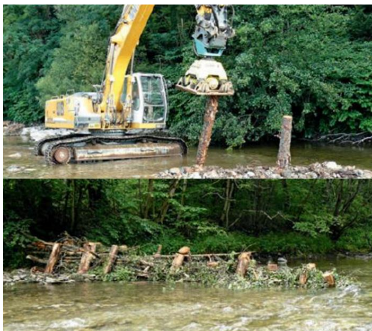
Obr. 56. – 57.: Výstavba výhonu z větví jištěných velkými kůly (nahore) a dokončený výhon (dole) (Linsin, 2018)
