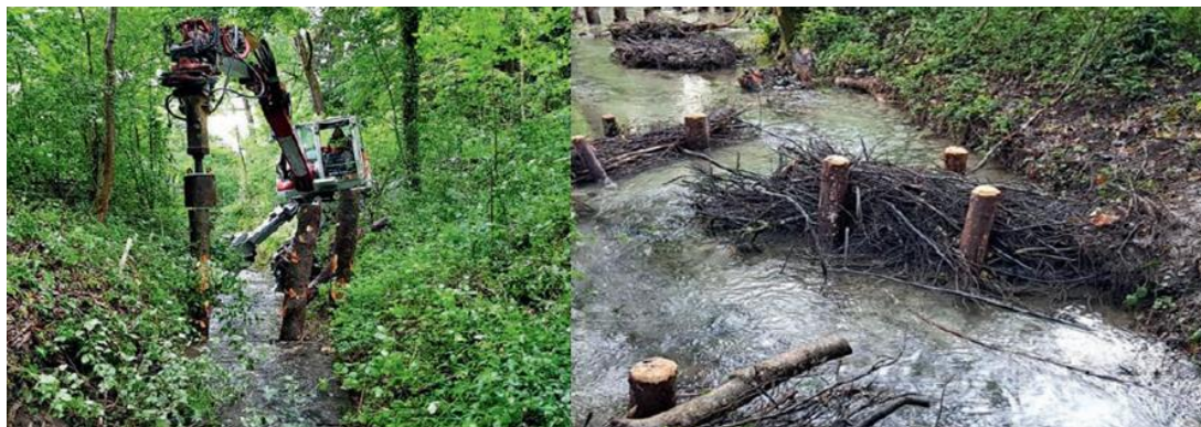
Obr. 52. – 53. Osazování velkých dřevěných kůlů do toku (vlevo) a jejich naplnění větvemi (vpravo) (Hausammann, 2018)
