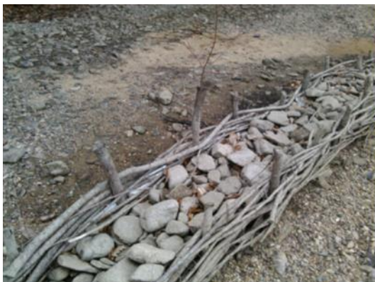
Obr. 95. Dvě řady zápletkových plůtků vysypaných kamenivem (vlevo) (Šlezinger, 2015)
