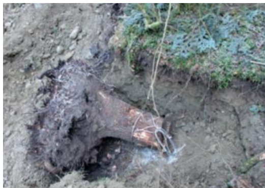
Obr. 148. Pařez s kotevním kamenem při vložení do koryta (vlevo) (Meier, 2018)
