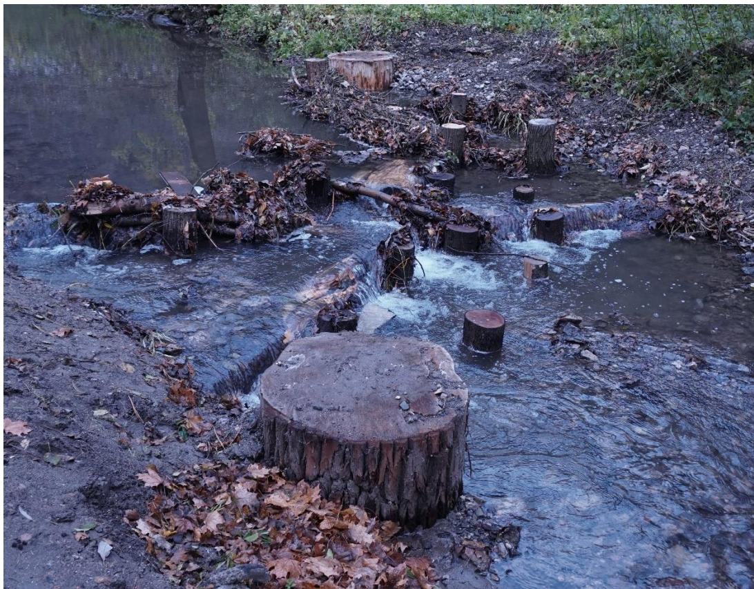
Obr. 194. Skluz z kulatiny zabezpečený kůly – experimentální stavba (Kožený, nepublikováno)
