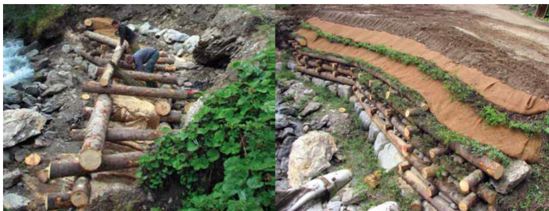
Obr. 138. – 139. Výstavba břehového opevnění (Bonin, 2013)
