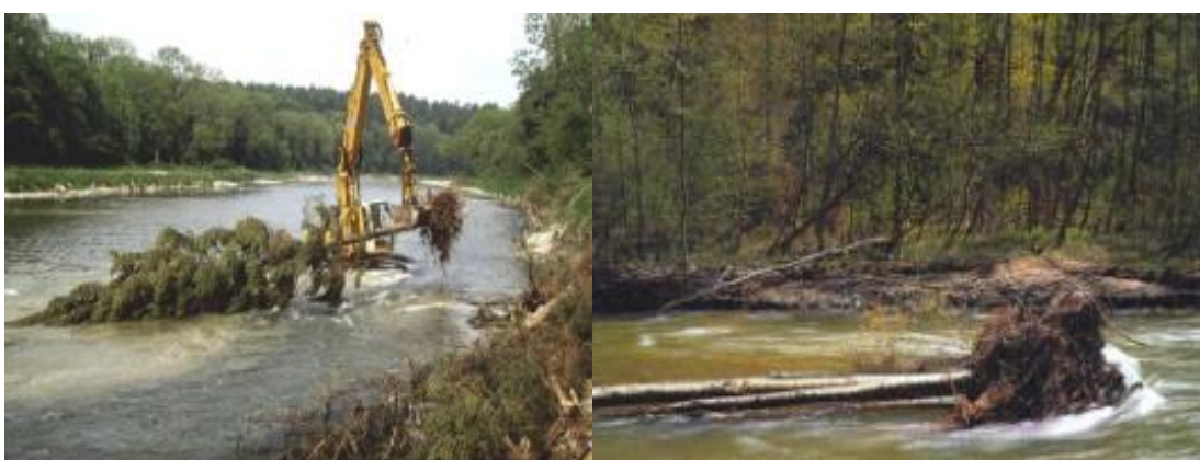
Obr. 172. – 173. Vkládání stromu do toku pomocí těžké techniky (vlevo) a již uložené stromy (vpravo) (DVU, 2020)
