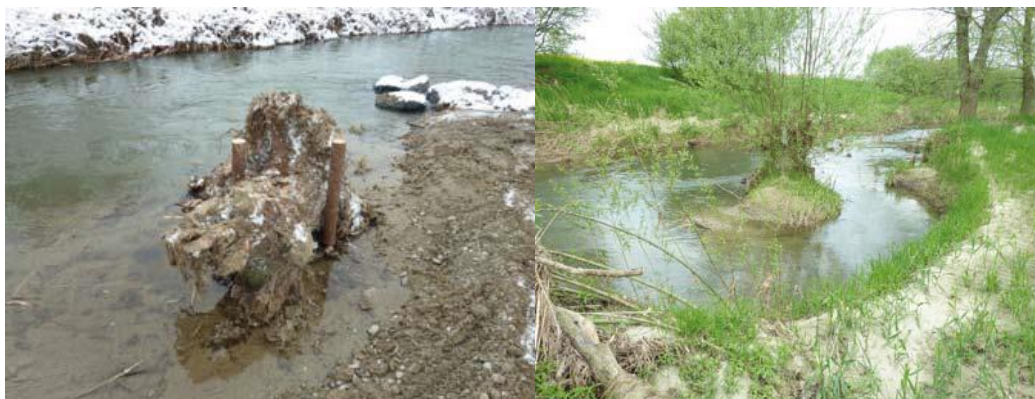
Obr. 155. – 156. Pařez po instalaci do toku, rok 2010 (vlevo) a stav toku v roce 2013 (vpravo) (Jany, 2013)
