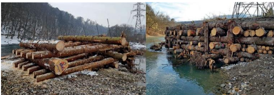
Obr. 86. – 87. Velká kmenová a kamenná opatření k ochraně břehu se sloupem elektrického vedení (Hartmann, Hausammann, 2018)
