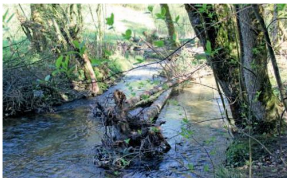
Obr. 168. Použití vyvrácených stromů z nedalekého okolí toku (Hartmann, 2018)
