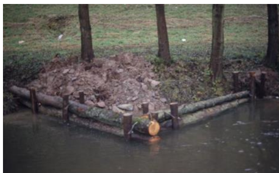
Obr. 81. Trojúhelníkový kmenový výhon vyplněný kameny, zeminou a zbytky dřevní hmoty (vlevo) (GFG, 2009)
