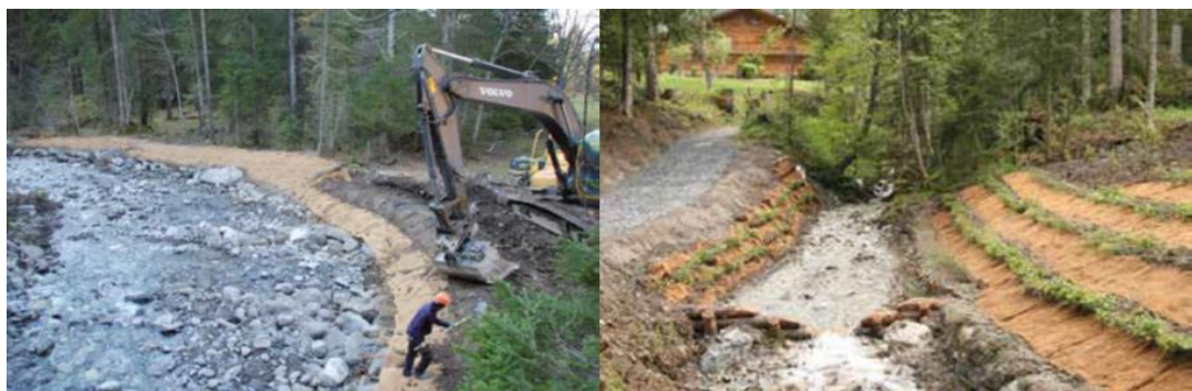
Obr. 121. – 122. Výstavba břehového opevnění (Bonin, 2013)
