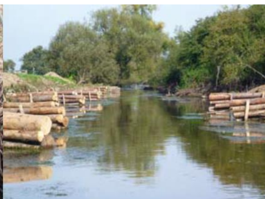
Obr. 35. Kmenové pyramidy uložené do břehů (Jany, 2013)
