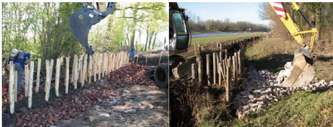
Obr. 185. – 186. Instalace kůlů (vlevo) zajištění pomocí kameniva (vpravo) (Jany, 2013)
