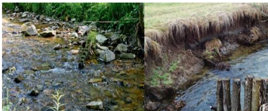
Obr. 135. – 136. Kůlové hřebenů k usměrnění proudění (vlevo – Linsin, 2018), (vpravo – Lamberty, 2020)
