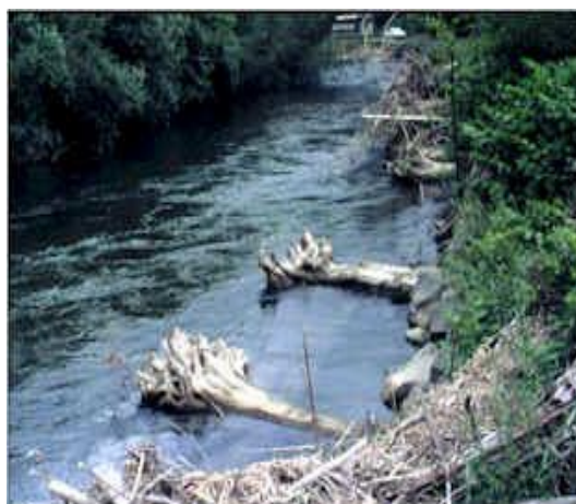
Obr. 47. Kmeny vyvrácených stromů upevněné svými dřívky do břehu toku (FGS, 2010)
