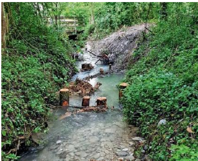
Obr. 181. Kmenové kůly uložené hluboko slouží jako lapače plavenin (Hausammann, 2018)
