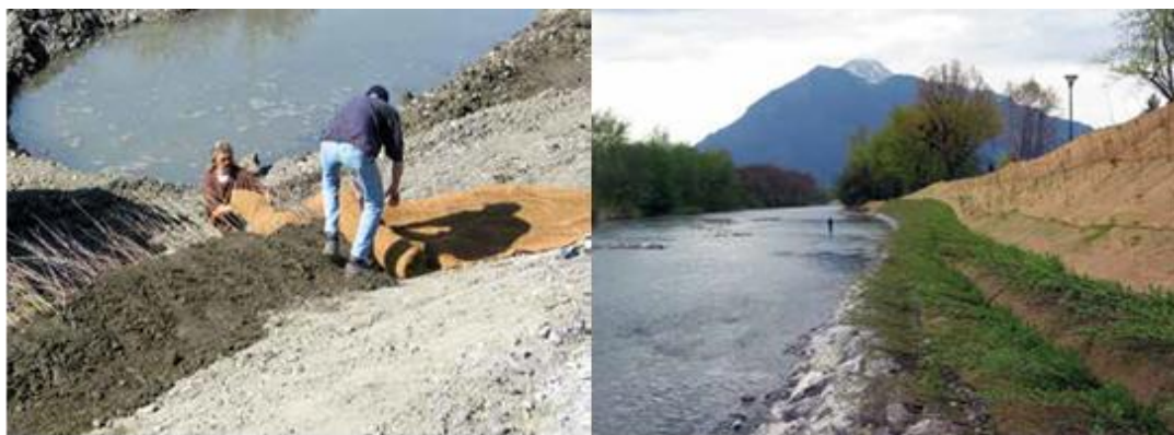
Obr. 126. – 127. Výstavba břehového opevnění (Bonin, 2013)
