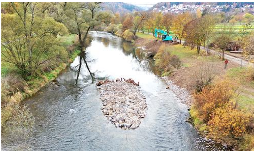
Obr. 144. Kamenný ostrůvek doplněný dřevními prvky (Regierungspräsidium Tübingen, 2018)
