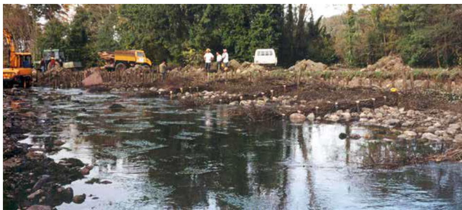
Obr. 108. Pruty a kůly instalované do břehu (Bonin, 2013)
