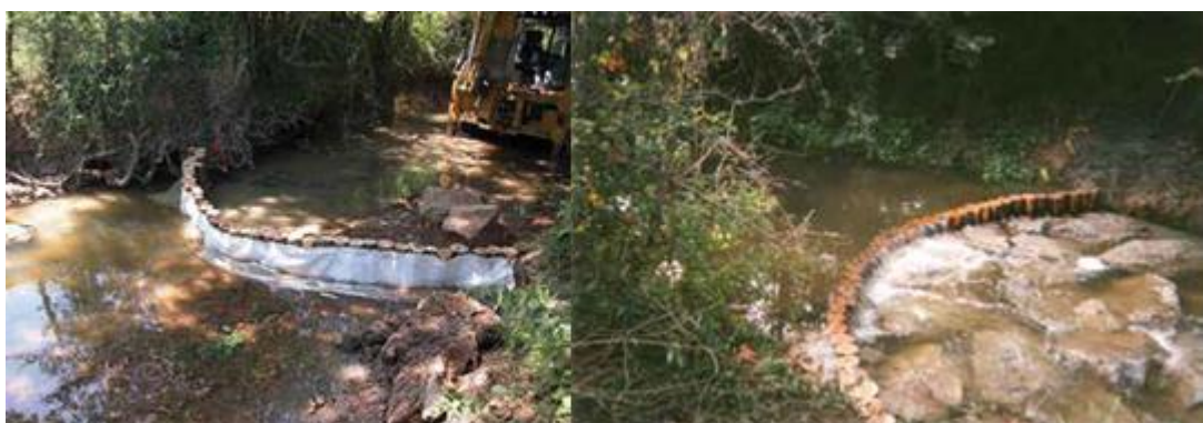
Obr. 179. – 180. Průběh prací na nízkém obloukovém prahu z dřevěných kůlů (vlevo) a již funkční prahová stavba (vpravo) (Bonin, 2013)
