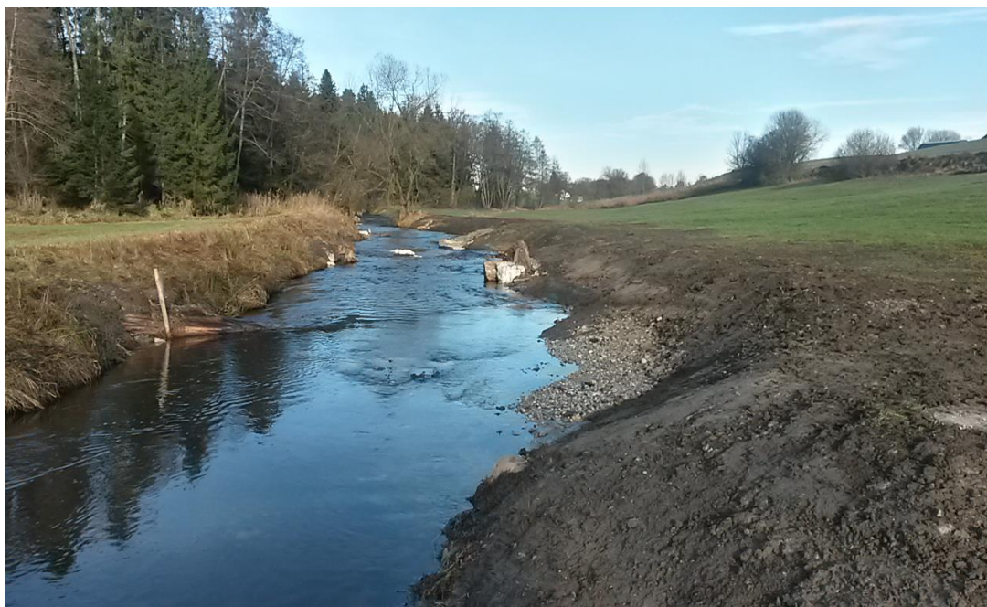
Obr. 28. Vestavba prvků z mrtvého dřeva a těžkých kamenů vytváří novou přirozenou trasu říčky (WWA, 2016)
