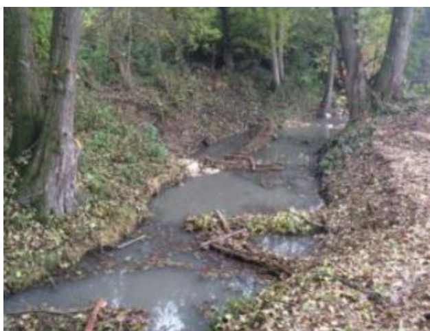
Obr. 67. Trojúhelníkový haťový nevyplněný výhon (WWA, 2016)
