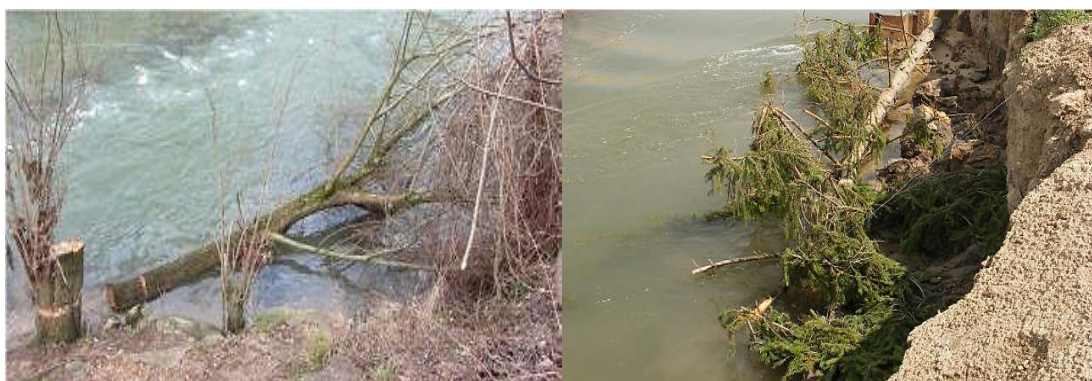
Obr. 40. – 41. Celé stromy ukotvené kůly a jištěné ocelovými lany (Walser, 2016)
