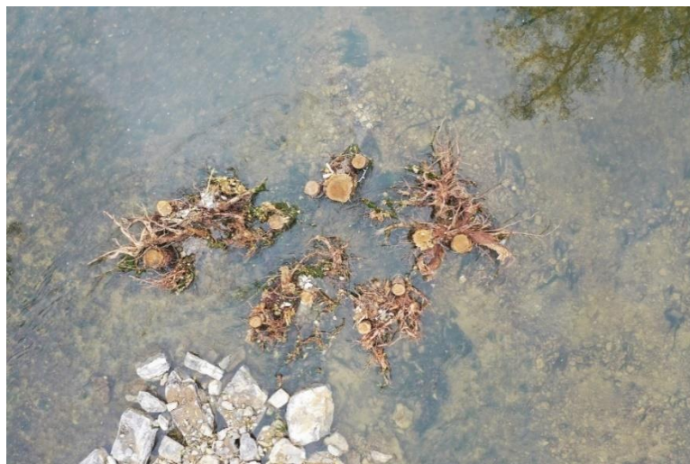
Obr. 158. Pařezy uložené ve dně pomocí kúlů a kamenů (Regierungspräsidium Tübingen, 2018)
