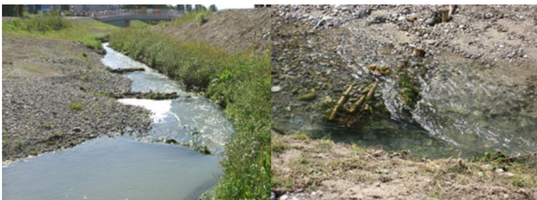
Obr. 61. – 62. Haťové válce zabudované v toku (vlevo) a (vpravo) zachycené plaveniny jako zdroj potravy pro bezobratlé (DBVU, 2020)
