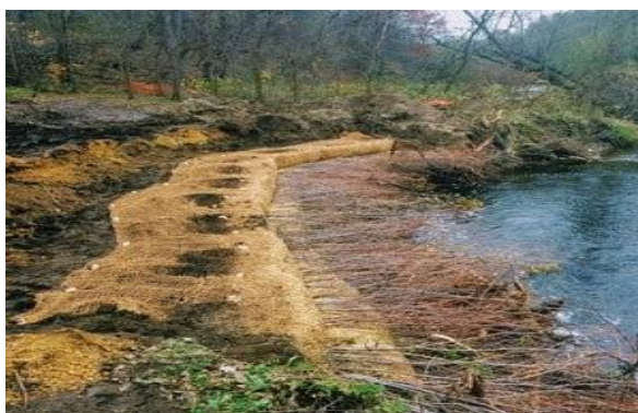
Obr. 125. Uchycení prutů kůly do břehu pomocí textilie z kokosového vlákna (NRP, 2019)
