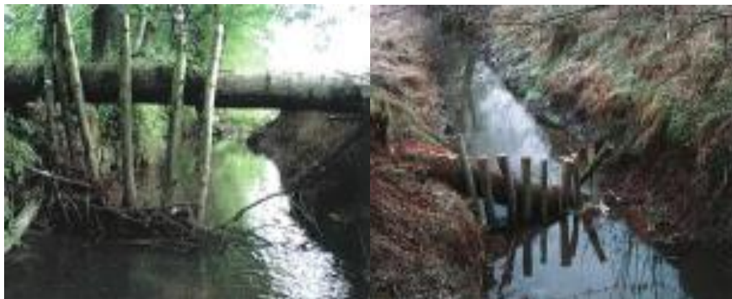
Obr. 183. – 184. Lapač pevněný kmenem po celé délce toku (vlevo) a zkosený jen k jednomu břehu (vpravo) (Gebler, 2005)
