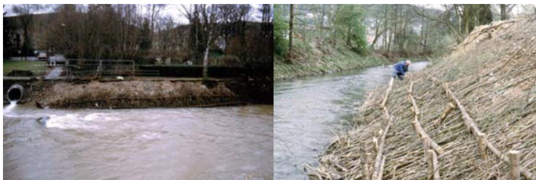
Obr. 106. – 107. Smrkové kůly uložené kolmo na pruty zajišťují pruty k obnovení břehové vegetace (Jany, 2013)
