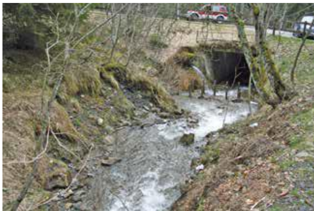
Obr. 180. Kůly instalované jako lapače před přemostěním toku (Bonin, 2013)
