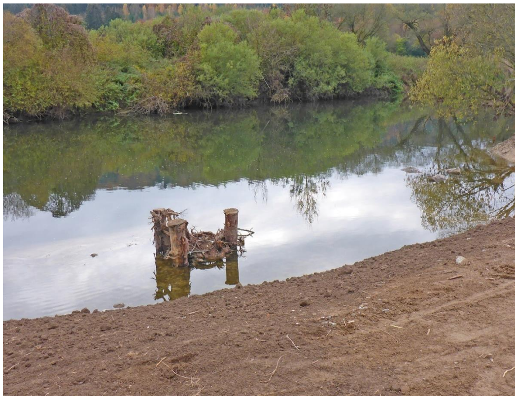
Obr. 162. Pařez uložený pomocí kůlů a ocelových lan (Regierungspräsidium Tübingen, 2018)
