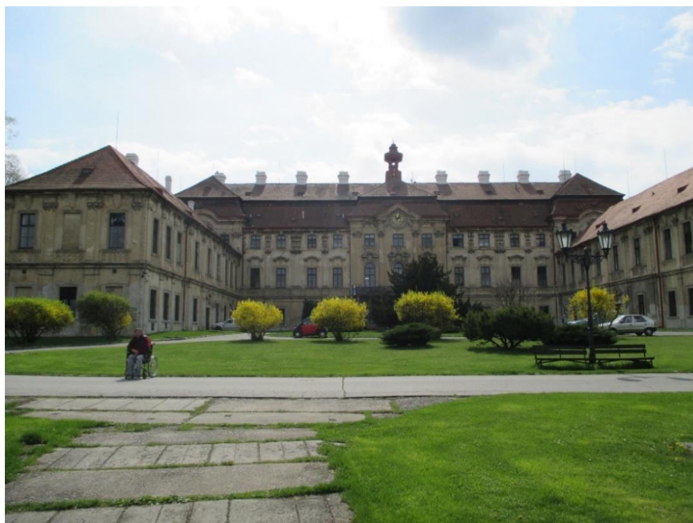
Obrázek 4: Čelní, severní strana zámku s čestným dvorem. Foto: Jan Vachuda.
