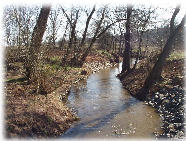
Obr. 14. – Na obrázku je opevnění těžkým kamenným záhozem, odpovídající prvnímu návrhovému profilu (zdroj - archiv POH)
