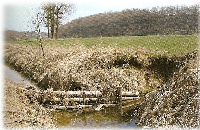
Obr. 10. Staveň z kulatiny, postavený v počátcích revitalizačních pokusů (Just. T., 2005)
