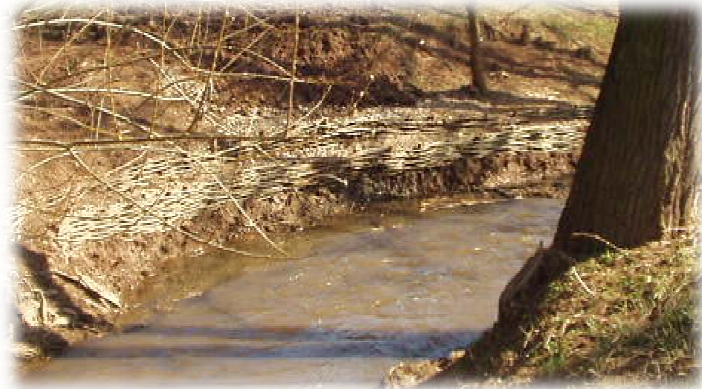
Obr. 15. opevnění oživenou srubovou stěnou ( zdroj - archiv POH)
