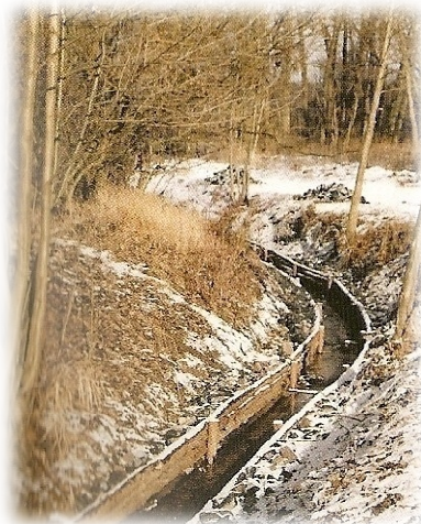
Obr. 9. Opevnění koryta laťovým plůtkem (Just. T., 2005)
