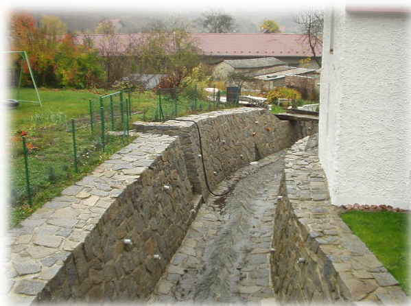
Obr. 2. Dlažba do cementové malty použitá jako opevnění v intravilánu města (zdroj – archiv POH)
