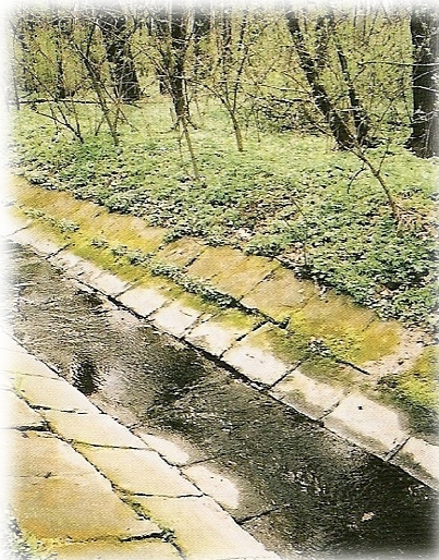
Obr. 7. Použití betonových tvárnic na opevnění vodních toků
