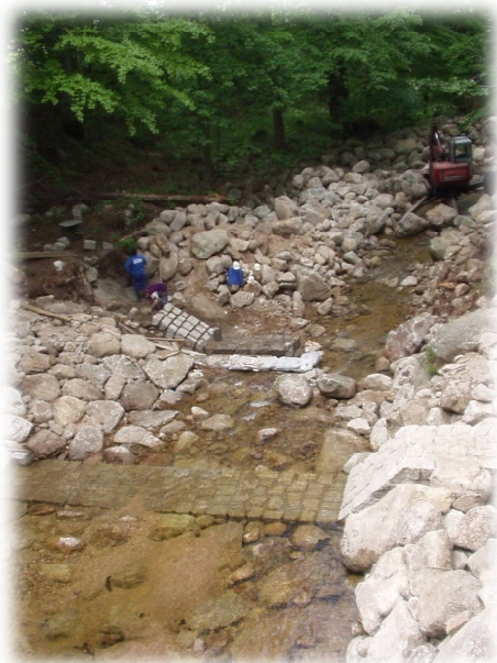
Obr. 5. Na obrázku je opevnění kamennou rovnatinou s využitím místních zdrojů zajištěné pasy z lomového kamene na cementovou maltu (zdroj – archiv POH)
