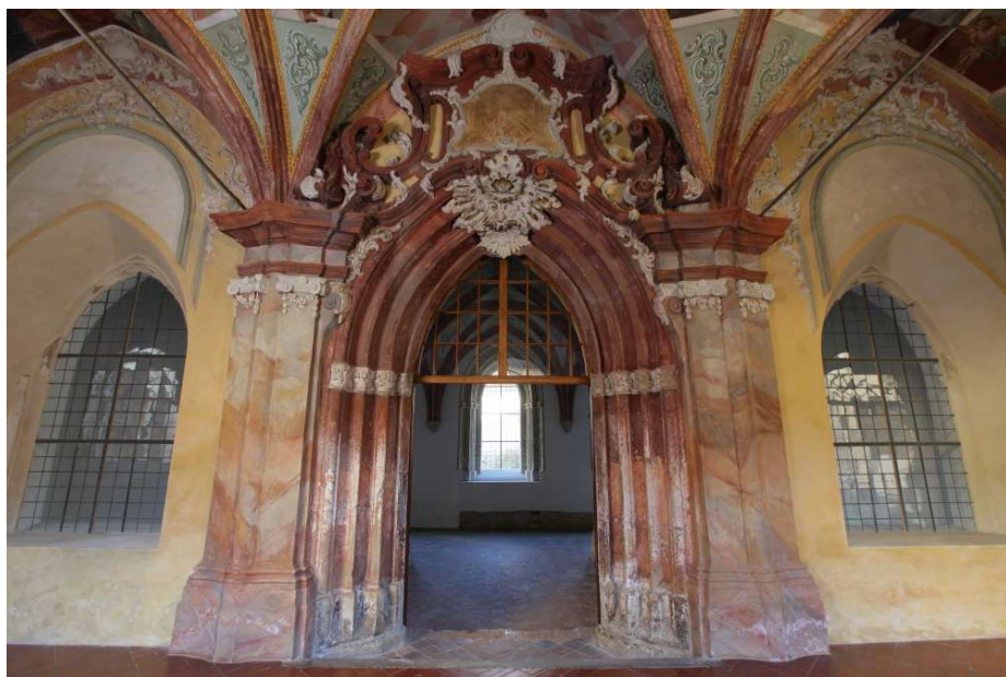
Obr. 5: Vstupní portál do kapitulní síně, klášter Zlatá Koruna
