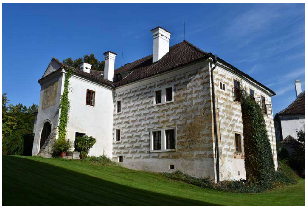
Obr. 9: Budova malého konventu, klášter Zlatá Koruna
