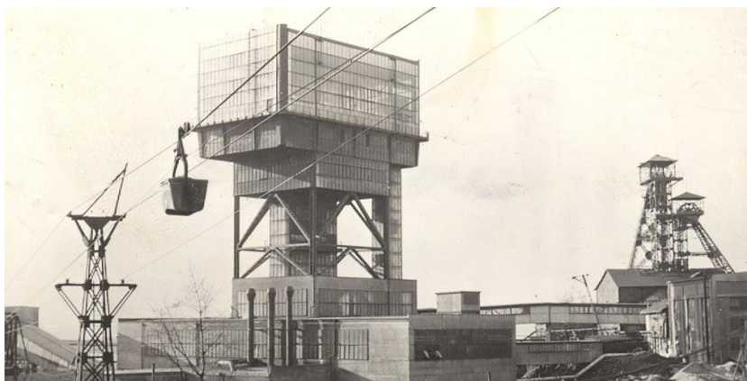
Obrázek 60: Trasa 4: Důl Petr Bezruč – lanovka spojující důl s koksovnu Karolinou, kladivová těžní věž a vpravo sdružená těžní věž, zdroj: Zdař Bůh (2009)
