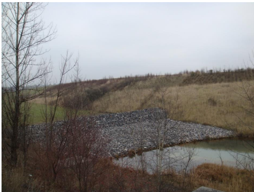
Obrázek 14: Lokalita Louky – „Osmá stavba“ (foto autor)
