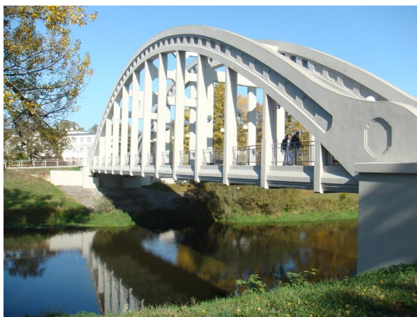
Obrázek 54: Trasa 2: Betonový obloukový most Sokolovských hrdinů přes řeku Olši (foto autor)
