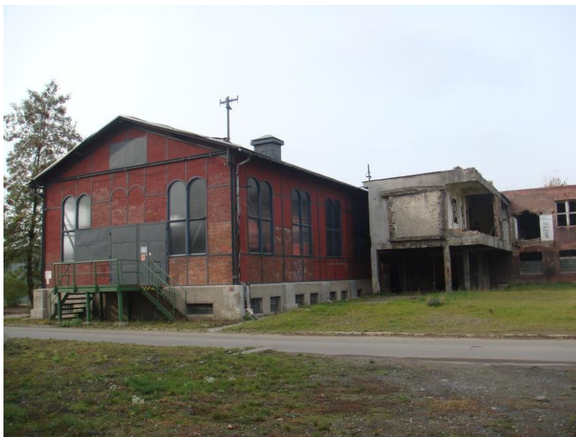
Obrázek 61: Trasa 4: Strojovna pomocného těžního stroje na Dole Petr Bezruč (foto autor)
