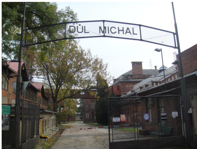
Obrázek 36: Důl Michal – vstup, vlevo těžní věž (foto autor)
