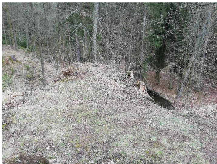
Obr. 28 – Pahorek sesypaného zdiva v jihovýchodním nároží parkánové hradby (foto autor )
