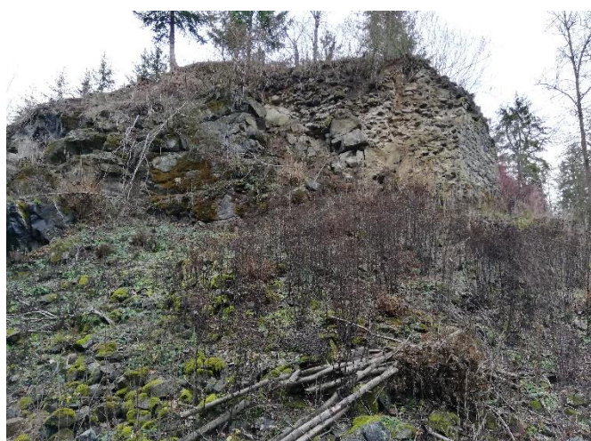
Obr. 24 – Jihozápadní nároží (foto autor )
