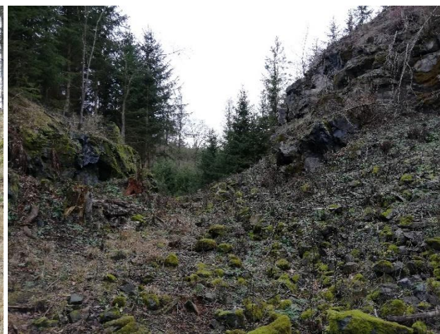
Obr. 10 – Pohled od jihu na zadní příkop (foto autor)
