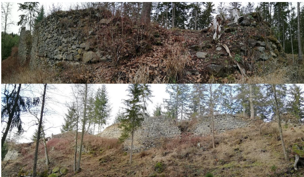
Obr. 18 – Pohled na jižní parkánovou zeď od jihovýchodního nároží a od jihu z údolí Janovického potoka (foto autor )
