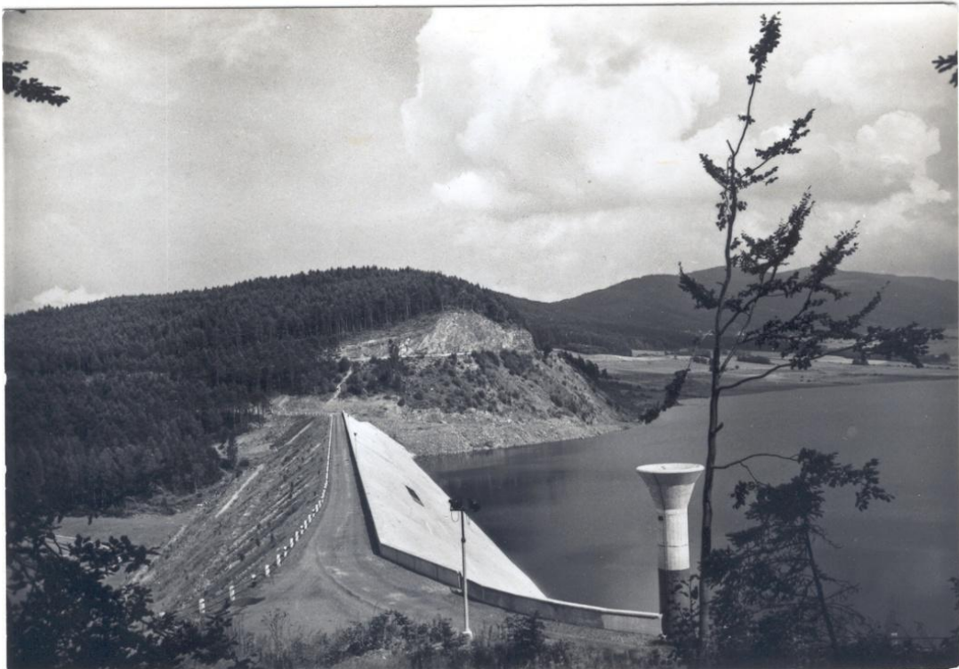
Obr. č. 4: První napouštění nádrže, zdroj: SOkA Klatovy, 2016
