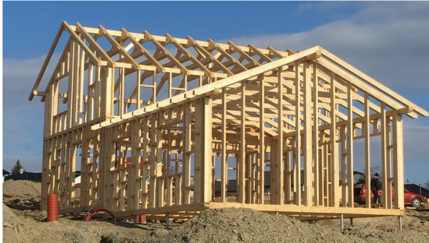
Obrázek 1 - Rámová konstrukce dřevostavby
