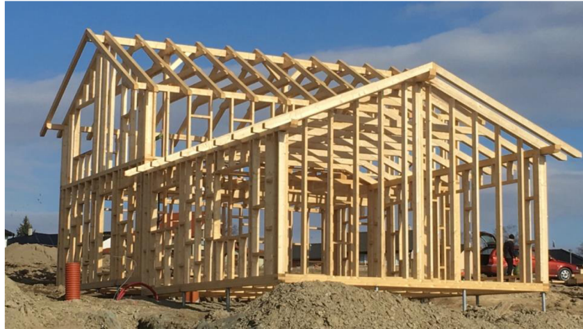
Obrázek 1 - Rámová konstrukce dřevostavby
