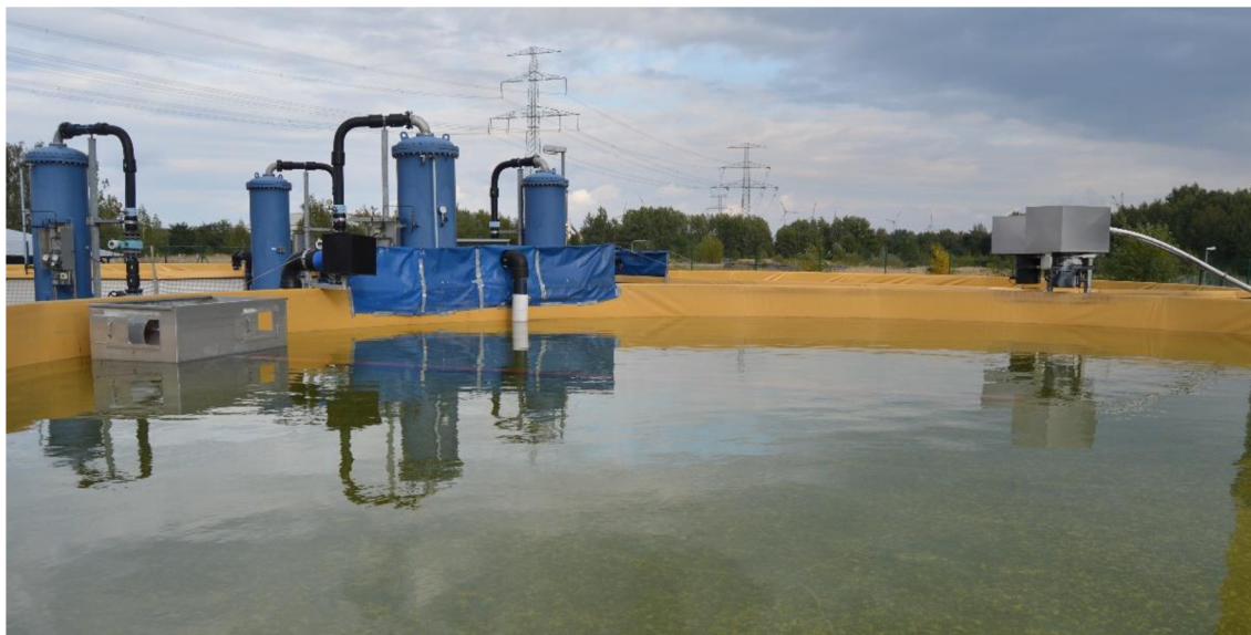
Obr. č. 4. Pohled na odchovnou nádrž v areálu Schwarze Pumpe (foto J. Regenda)
