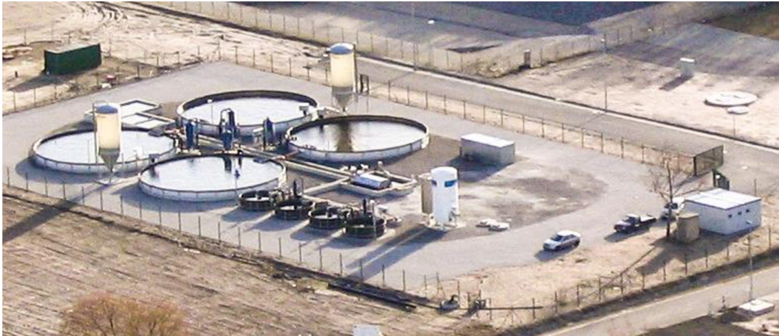
Obr. č. 3. Odchovný průtočný systém s odpadní oteplenou vodou, Schwarze Pumpe Německo (Rümmler a kol., 2011)
