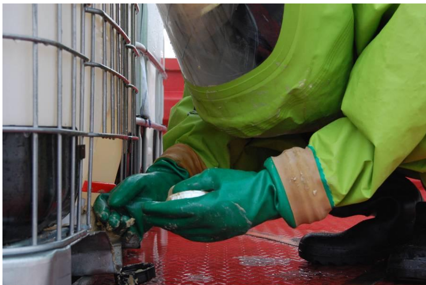
Obrázek 19 Utěsnění poškozeného ventilu pomocí tmelu (zdroj autor)
