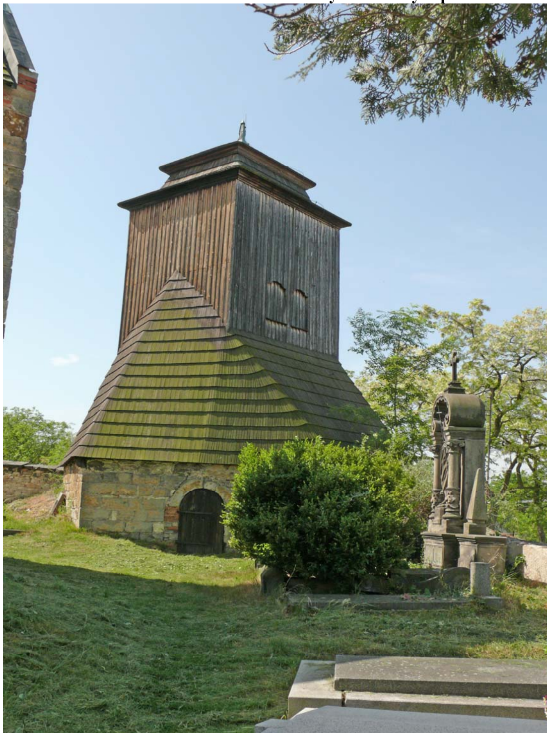
Příloha č. 10 – Želenice – zvonice s bedněným zvonovým patrem
