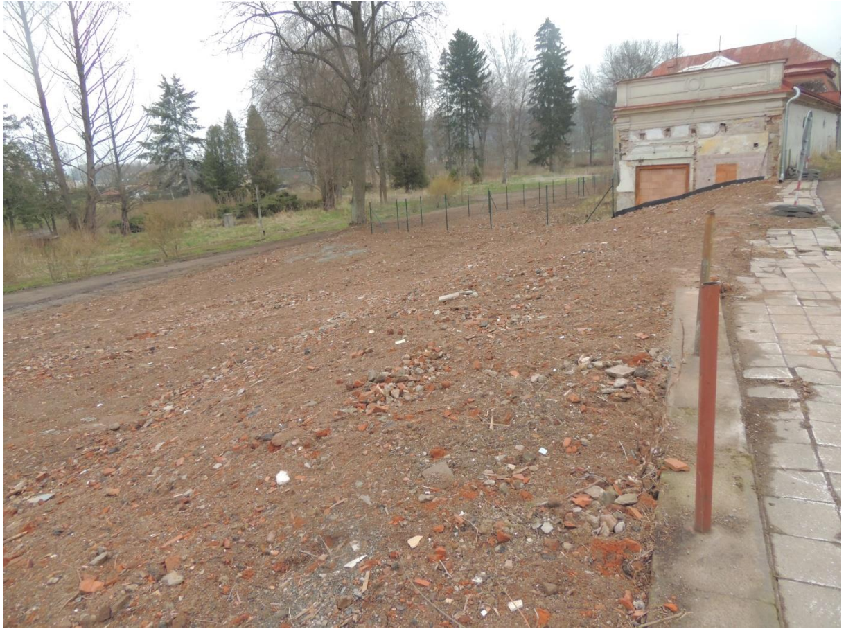
Obrázek 33: Pohled na trosky zbouraných budov lázní Běloves
