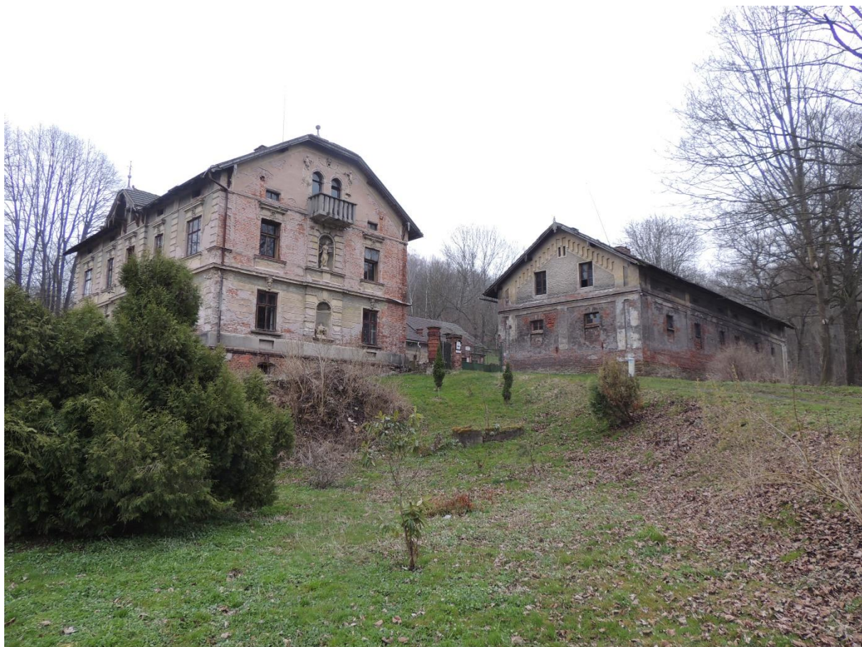
Obrázek 32: Dochované, nefunkční budovy lázní Bělaves
