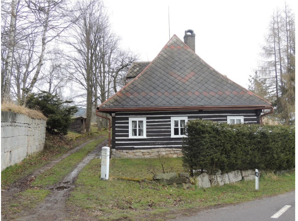
Obrázek 40: Dochované budova bývalé celnice
