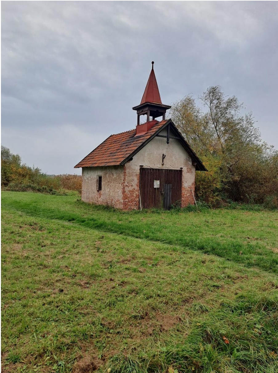
Obrázek 55: původní dochovaná hasičská zbrojnice
