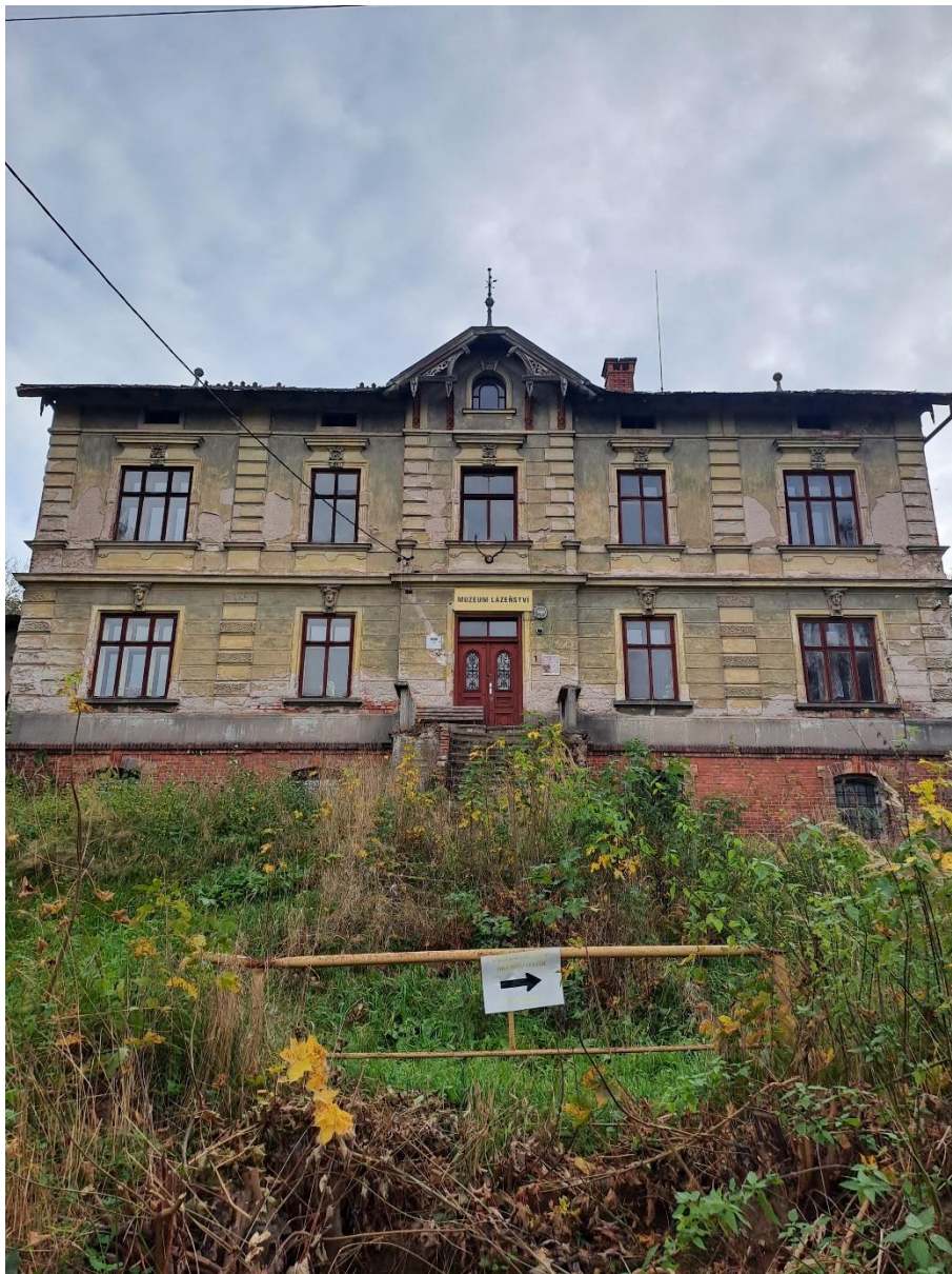
Obrázek 29: Původní lázeňská budova
