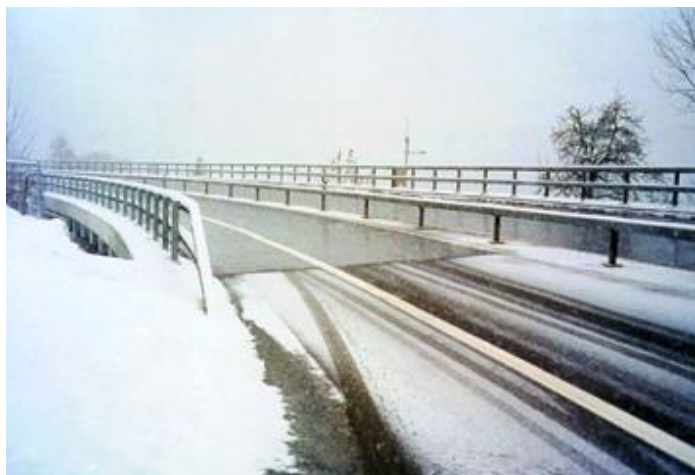
Obr. 2.10 Využití energetických pilot pro odmrazování mostní desky [11].
