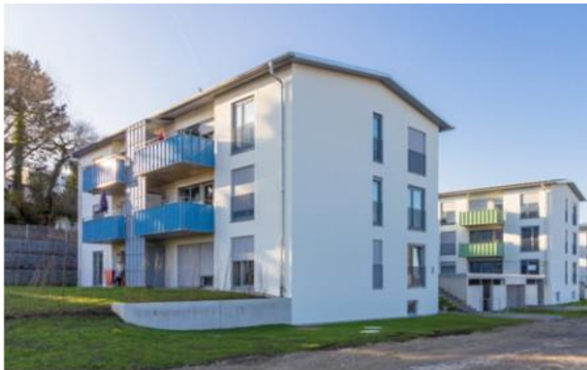
Obr. 2.21 Pohled na dvě budovy z východní strany [16].
