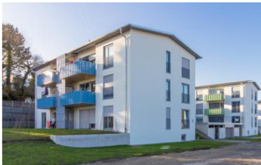
Obr. 2.21 Pohled na dvě budovy z východní strany [16].
