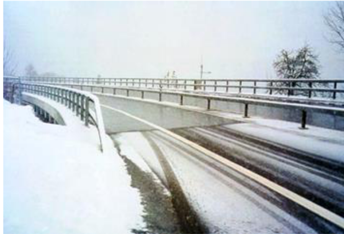
Obr. 2.10 Využití energetických pilot pro odmrazování mostní desky [11].
