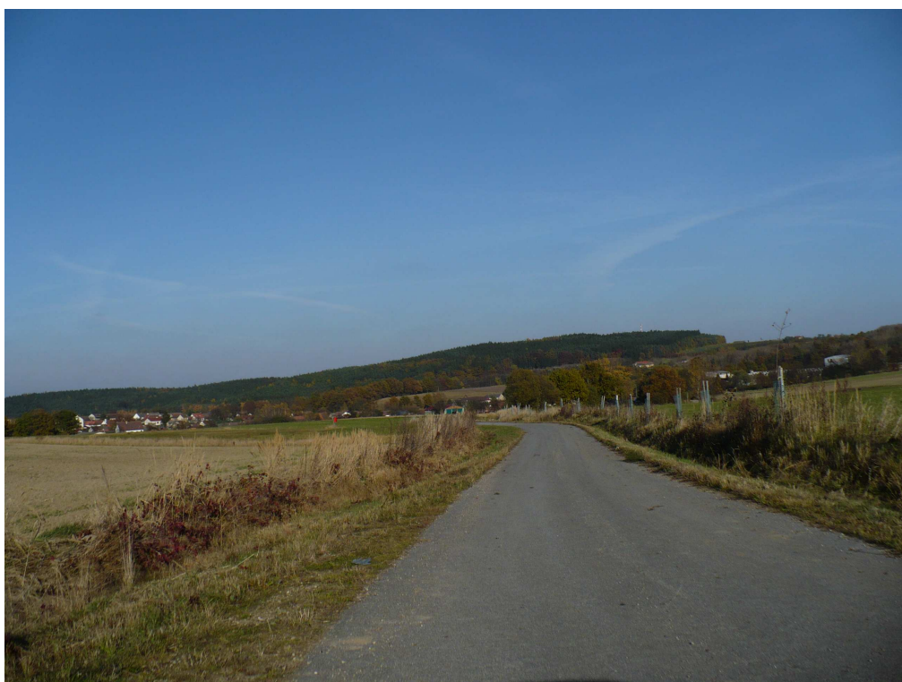
Foto č. 5: Nově zrekonstruovaná komunikace O4 (autor)
