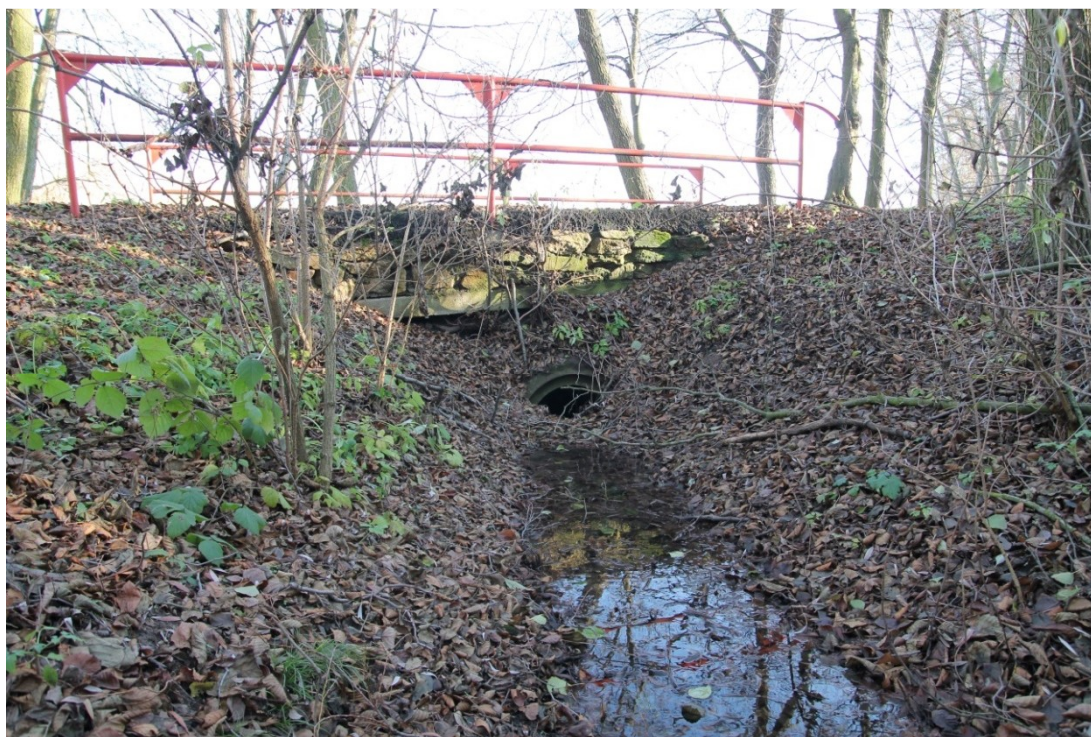
Obr. 22 KB 2 – most zpevněné polní nad rybníční nádrží
