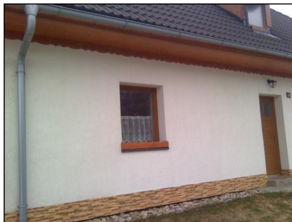
VIDITELNÝ LINÉARNÍ TEPELNÝ MOST V MÍSTĚ ZÁKLADOVÝCH PÁSŮ
