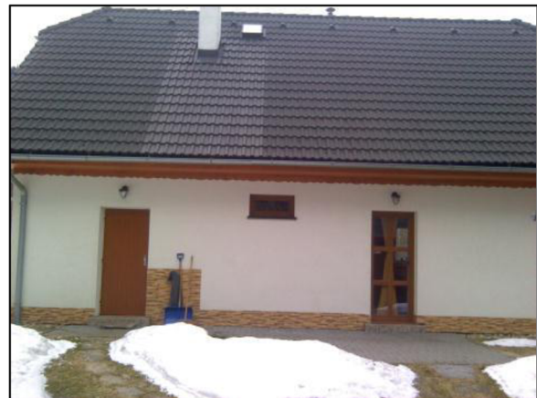
VIDITELNÝ LINERÁNÍ TEPLENÉ MOST V ÚROVNI ZÁKLADOVÝCH PÁSŮ A ZTUŽUJÍCÍHO VĚNCE
