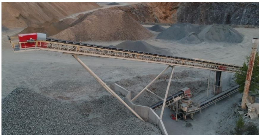
Obr. 35 Obslužná lávka (vlastní foto).
