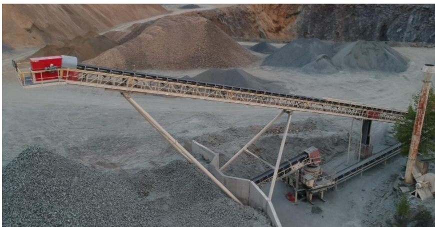
Obr. 35 Obslužná lávka (vlastní foto).
