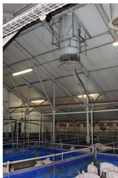
Obrázek 9 - Ventilátorová pračka vzduchu (BDTECH, 2017)
