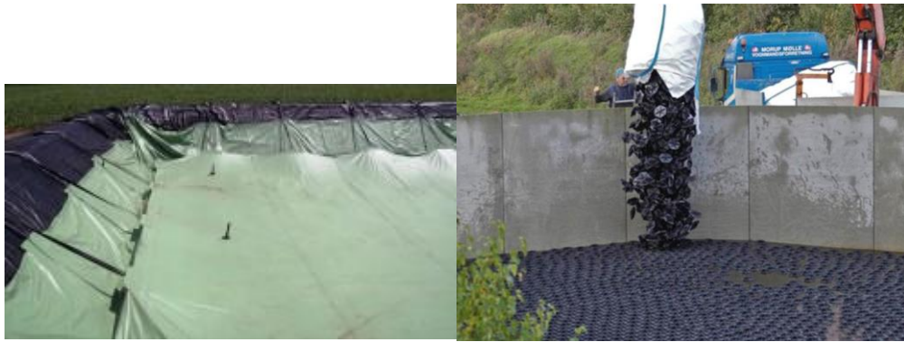
Obrázek 6 - Příklady zakrytí nádrží kejdy (BRUNNTHALLER, 2017)
