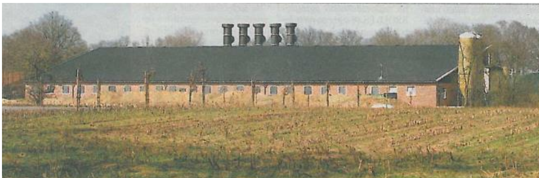
Obrázek 8 - Umístění ventilátorové pračky vzduchu (ZEMĚDĚLEC, 2017)
