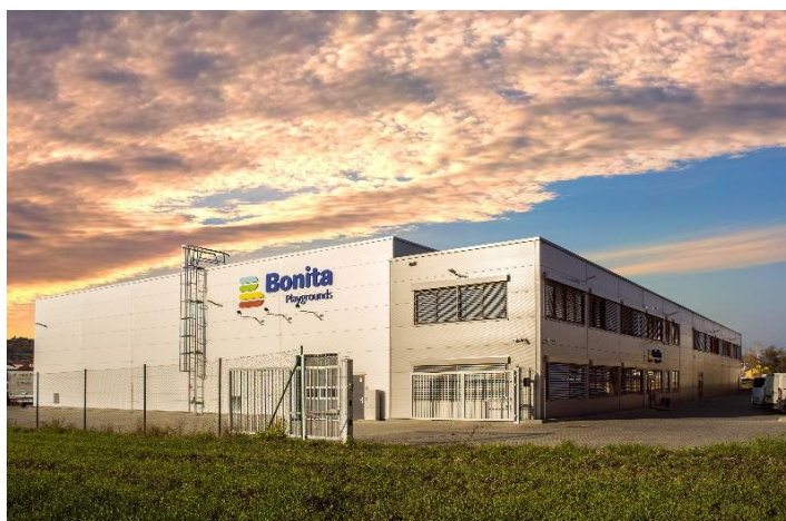
Obr. č. 8: Administrativní budova společnosti (vlastní zpracování)
