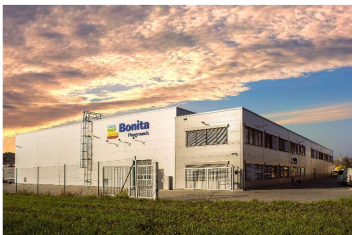
Obr. č. 8: Administrativní budova společnosti (vlastní zpracování)
