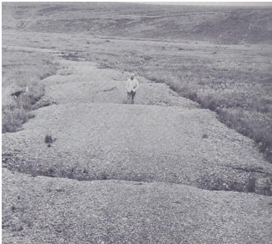
Obrázek 24 - Štěrková cesta poblíž Umiat kdy došlo k rozdílnmu sesedání půdy díky odtání ledových klínů pod cestou (Ferrians, et al., 1969)
