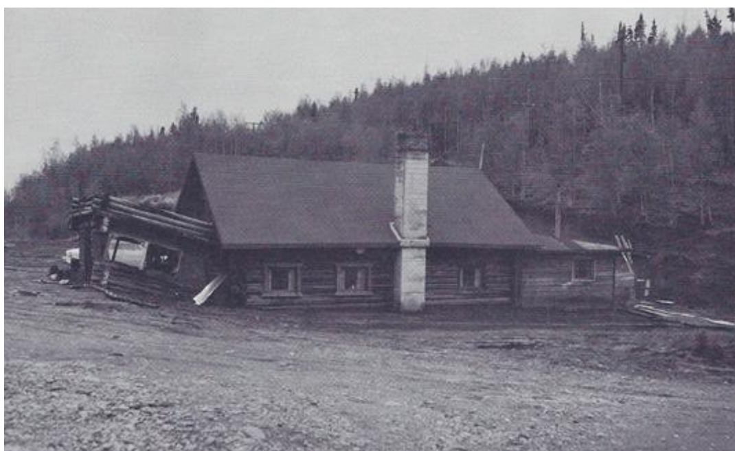
Obrázek 25 - Zdeformovaný zájezdní dům, ležící na Richardson Highway, který způsobilo narušení termální rovnováhy permafrostu (Ferrians, et al., 1969)
