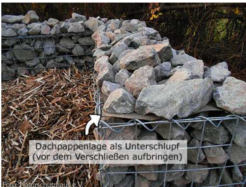
e) Detail svrchní části gabionu (Naturschutzhaus e.V.)
