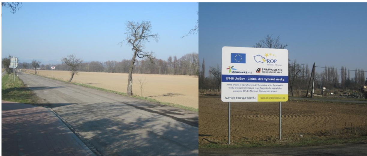
Obr. č. 23, 24: Vyfrézovaná vozovka Uničov – Nová dědina (vlevo); informační tabule o probíhající rekonstrukci (vpravo); (Pavlíková, 2/2015)
