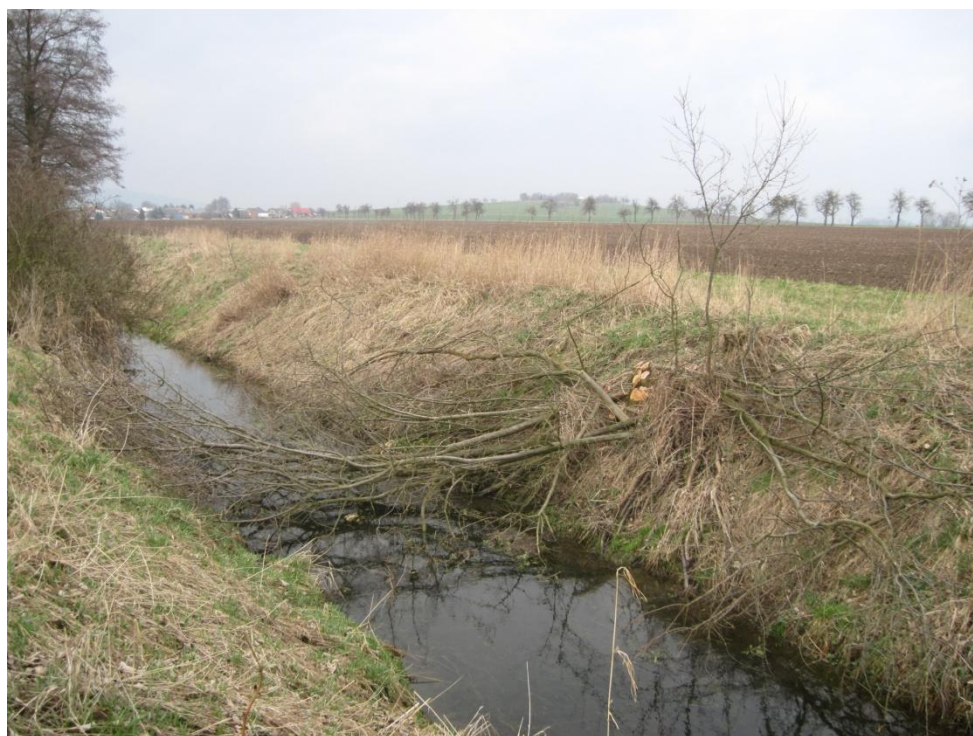
Foto č. 14: Koryto Benkovského potoka u mostní konstrukce na silnici z Benkova do Střelice (3/2015)
