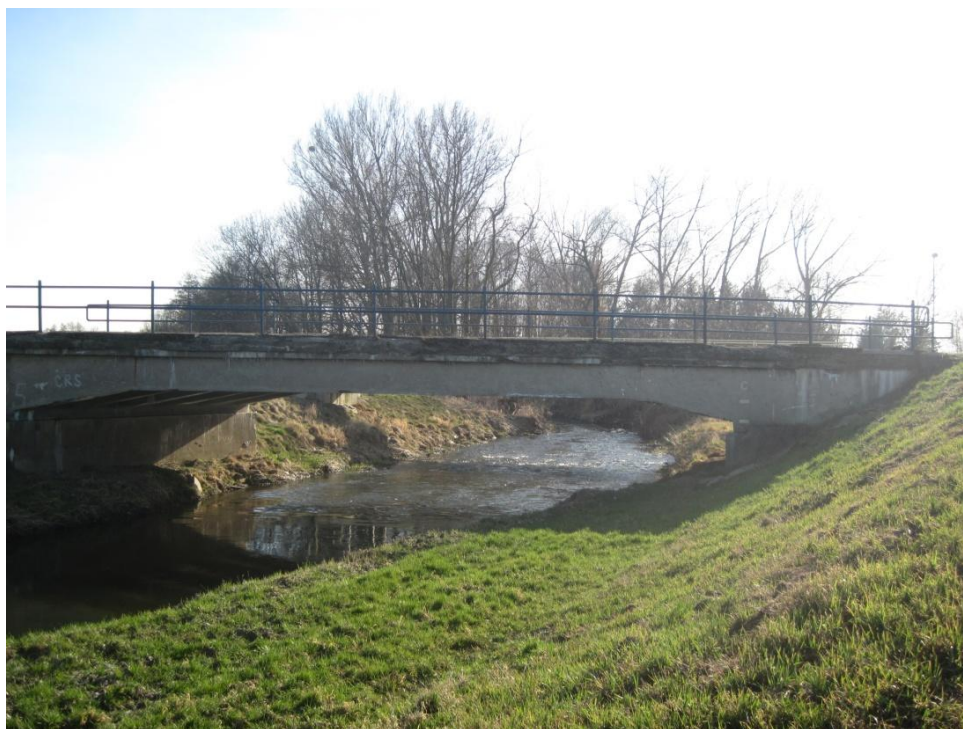
Foto č. 27: Mostní konstrukce silnice II/446 směr Uničov – Želechovice (3/2015)
