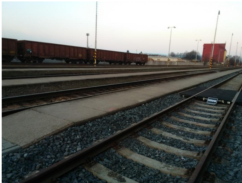
Obr. č. 26: Nově zrekonstruovaná dopravní plošina uničovského nádraží (Pavlíková, 2/2015)
