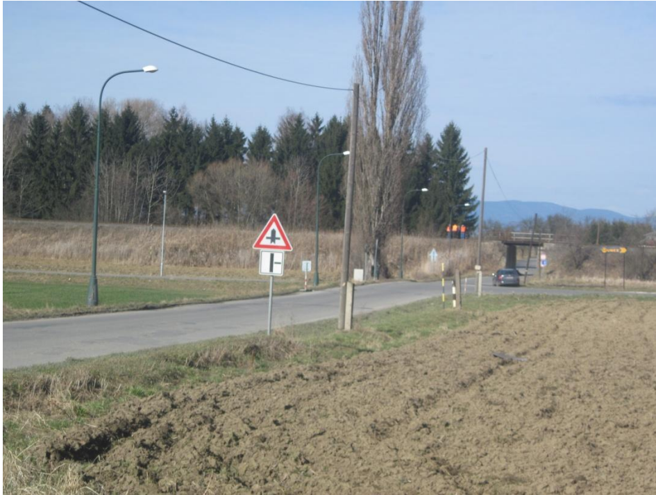
Obr. č. 28: Železniční dopravní násep ve směru Uničov zastávka – Uničov (Pavlíková, 2/2015)
