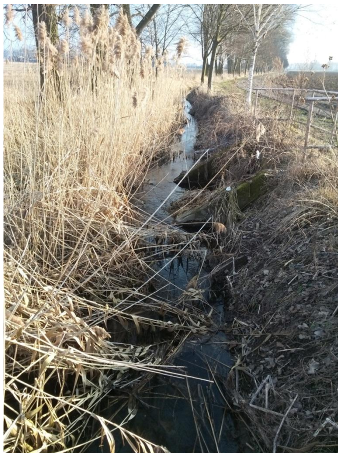
Foto č. 10: Neudržovaný stav vodního toku Lukavice (2/2015)
