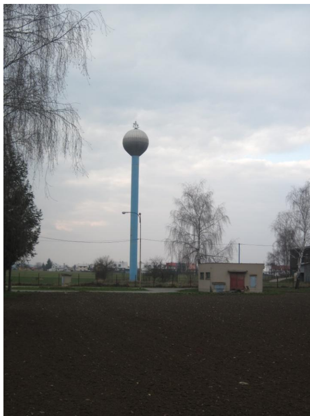
Foto č. 24: Věžový vodojem ve Střelicích (3/2015)
