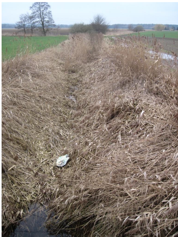
Foto č. 13: Zarostlé koryto Doubravského potoka u silnice II/449 (3/2015)
