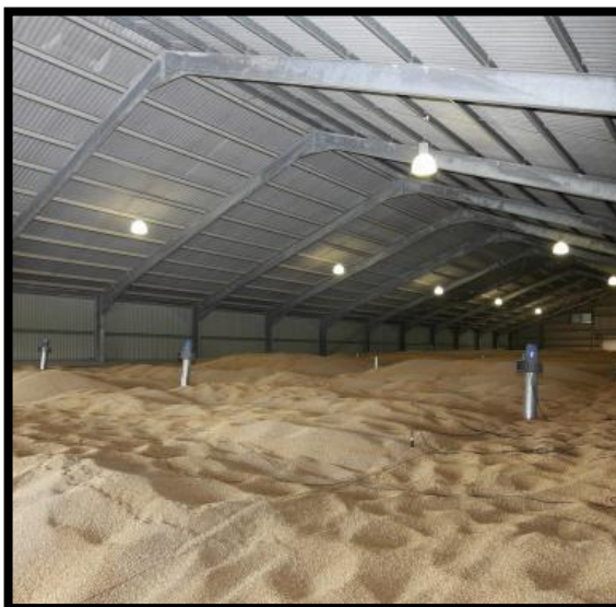
Obrázek 2 - Umístění pylonů ve skladu obilovin [1]
