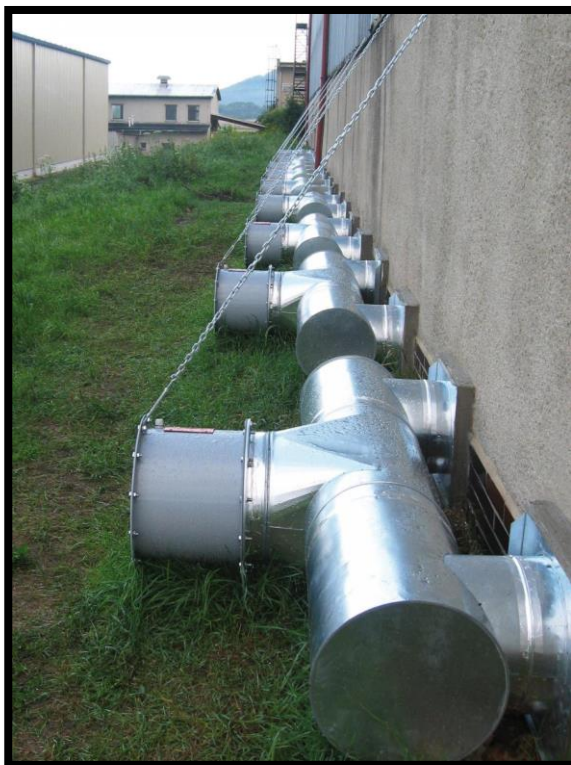
Obrázek 5 - Umístění ventilátorů napojených na podlahové větrání. [1]
