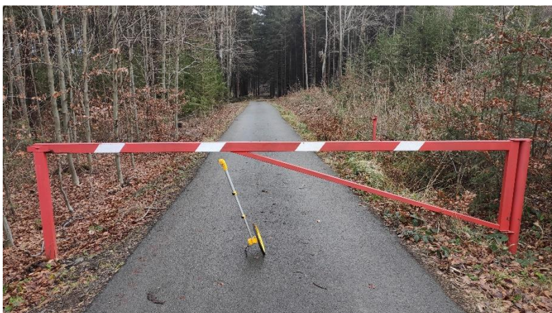
Obrázek 15 Nejčastěji se vyskytující varianta kovových uzamykatelných závor, varianta z kovových profilů na PE689_1
