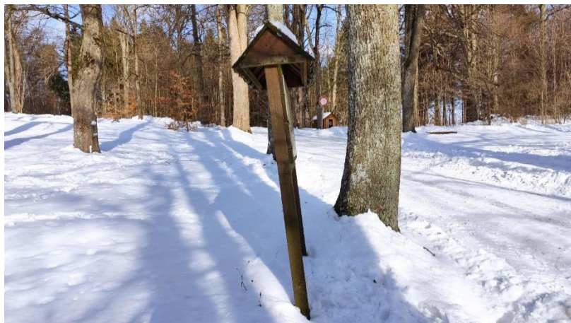
Obrázek 66 Poškozená informační tabule – nedostatečné kotvení v terénu + vhodné obnovení nátěru, označení ID: 1
