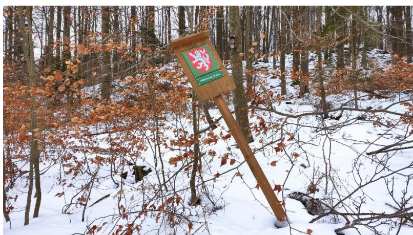
Obrázek 69 Poškozená informační tabule – nedostatečné kotvení, označení ID: 22
