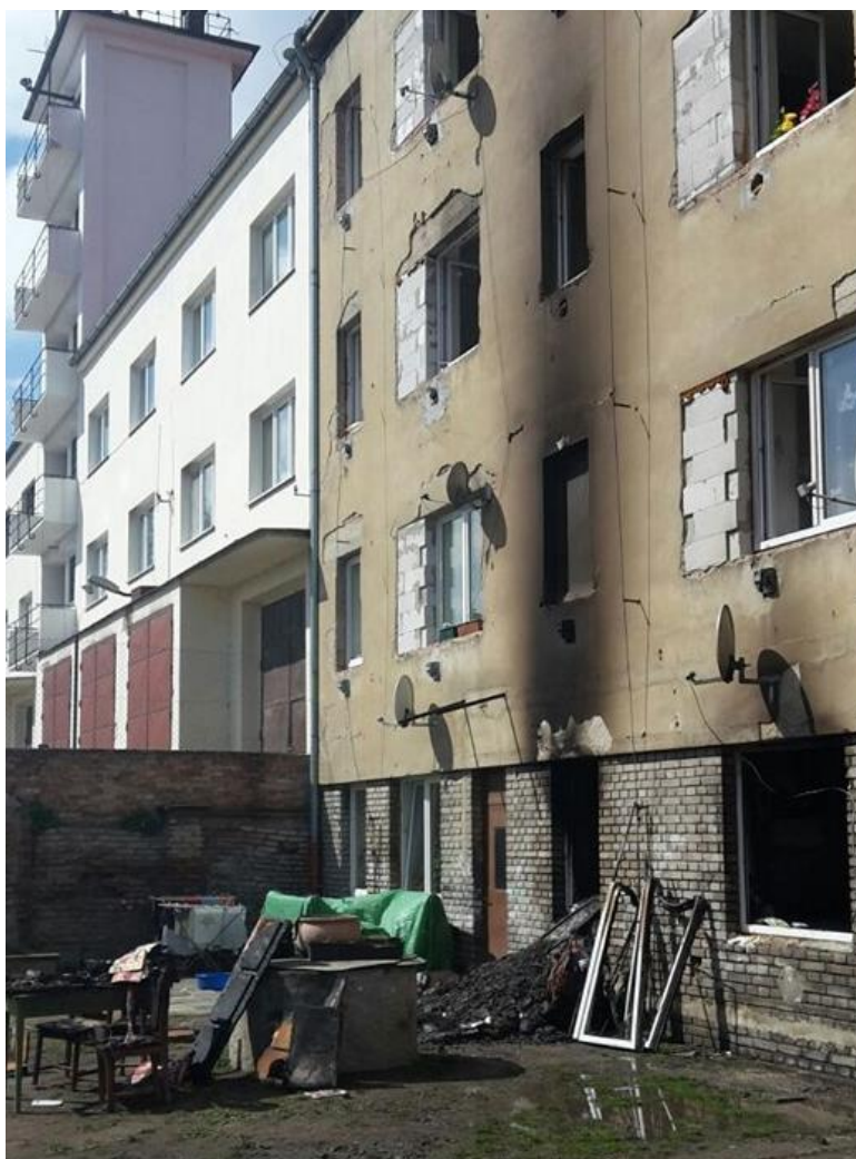
Obrázek č. 9: Požár bytového domu 6.4.2015
