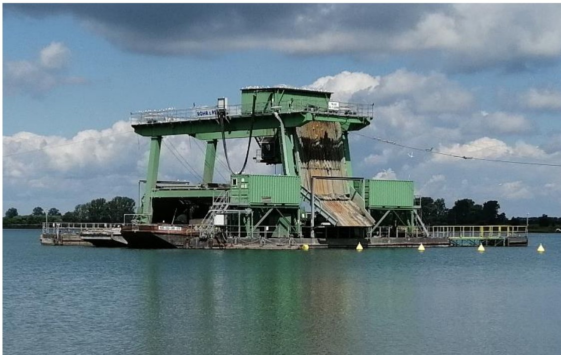
Obr. 1. 11 – Drapákový bagr na pontonu [6]
