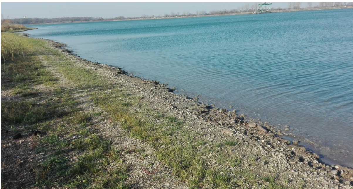
Obr. 5. 2 – Stav řešeného úseku (listopad, 2018) [7]
