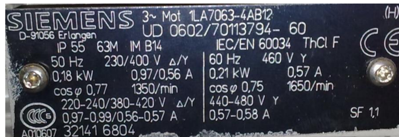
Obrázek 6.3 Výrobní štítek motoru
