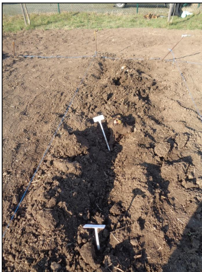
Obr. 8: Příprava rýhy pro výsadbu
