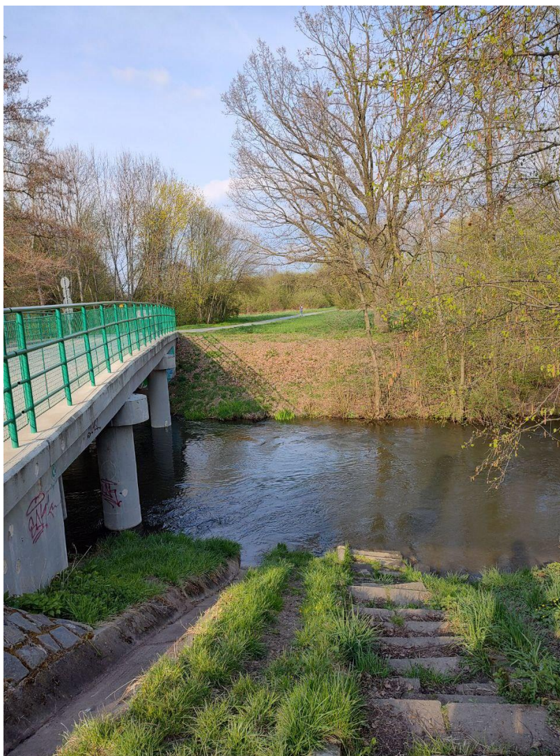
Obr. 9. Schodiště k třetímu odběrovému místu (archiv autorky)
