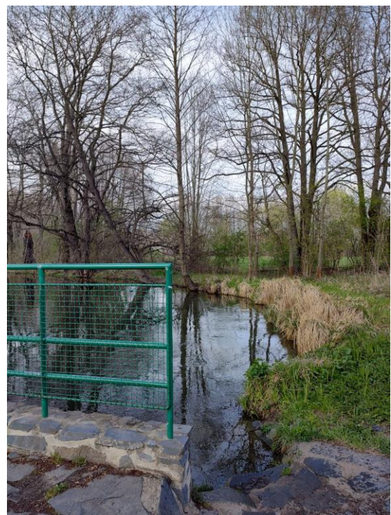
Obr. 8. Zpevnění břehu u základu mostu vedle druhého odběrového místa (archiv autorky)
