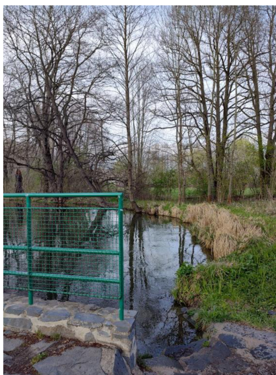
Obr. 8. Zpevnění břehu u základu mostu vedle druhého odběrového místa (archiv autorky)
