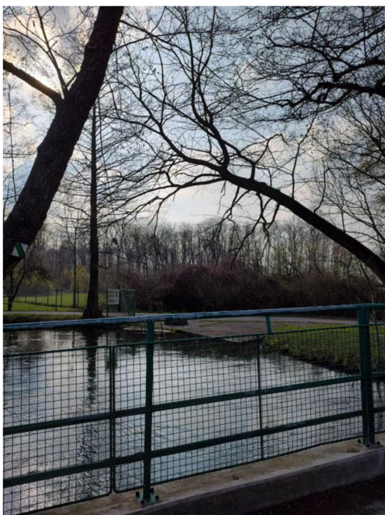
Obr. 7. Pohled na druhé odběrové místo z mostu (archiv autorky)
