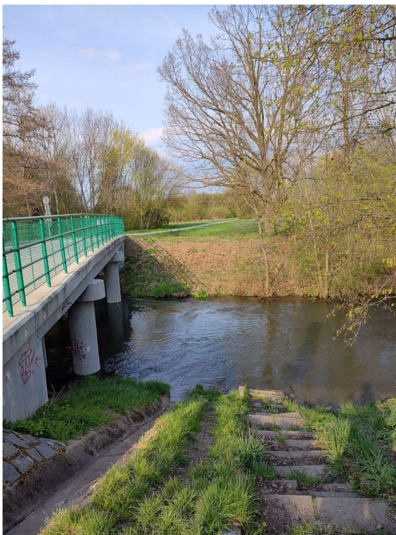
Obr. 9. Schodiště k třetímu odběrovému místu (archiv autorky)
