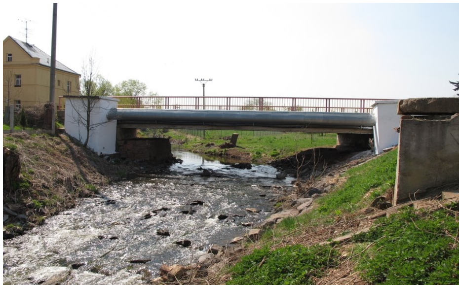
Obr. 4 – Silniční most v obci Kryry.
