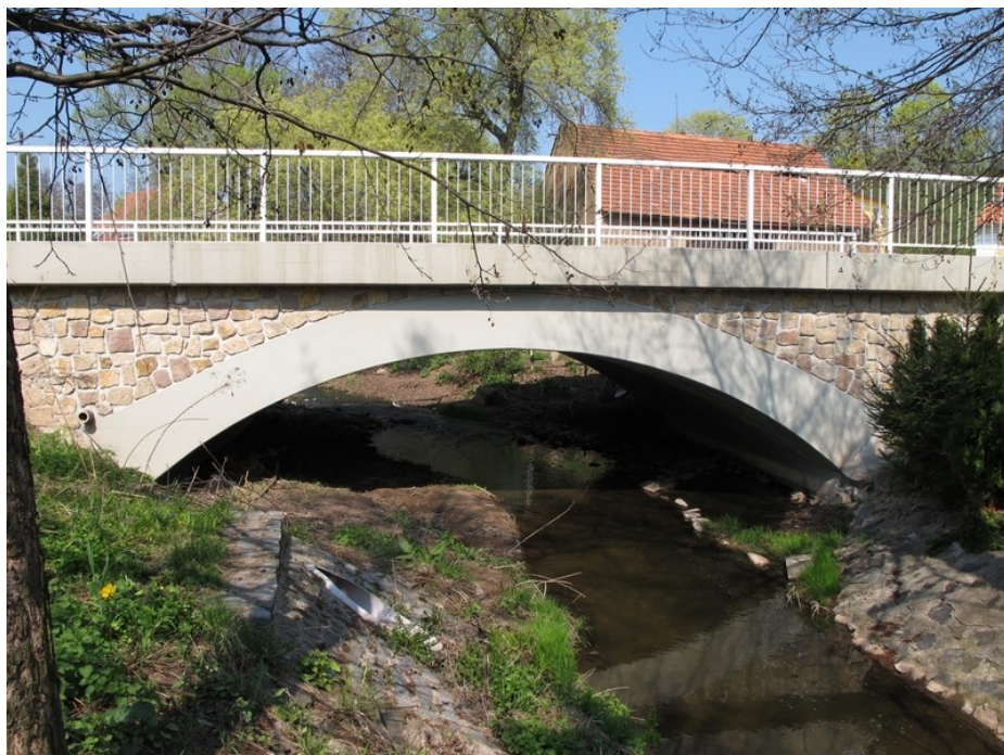
Obr. 8 – Blšanka – silniční most v Lubenci.
