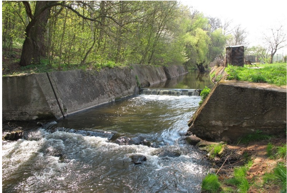
Obr. 5 – Blšanka – jez k čerpací stanici v Kryrech.
