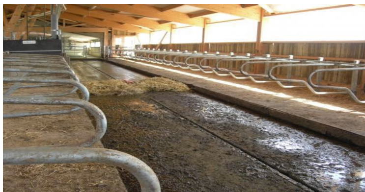
Obr. 13 Odvodný kanál pro kejdu s lanovou lopatou
