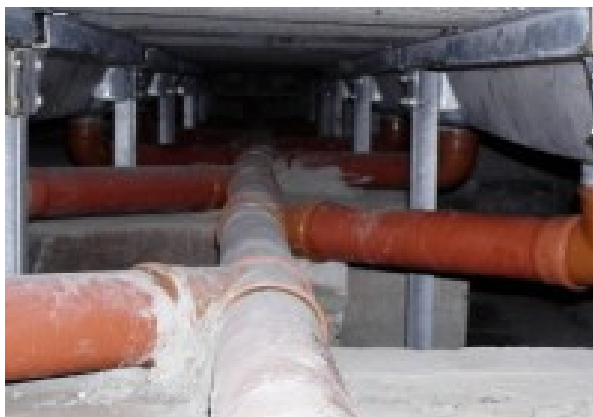
Obr. 18 Zátkový systém – odvody kejdy kanalizací
