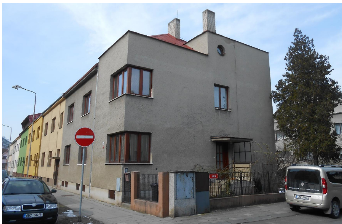
135. Přerov, dům pana Smutného a paní Čurdové, současný stav 2018; fotografie autorky
