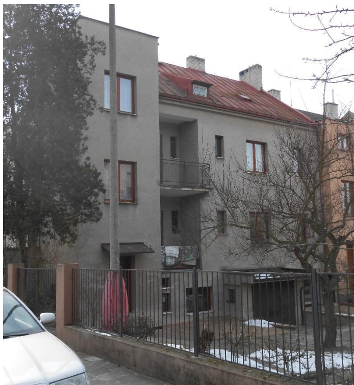
136. Přerov, dům pana Smutného a paní Čurdové, současný stav 2018; fotografie autorky
