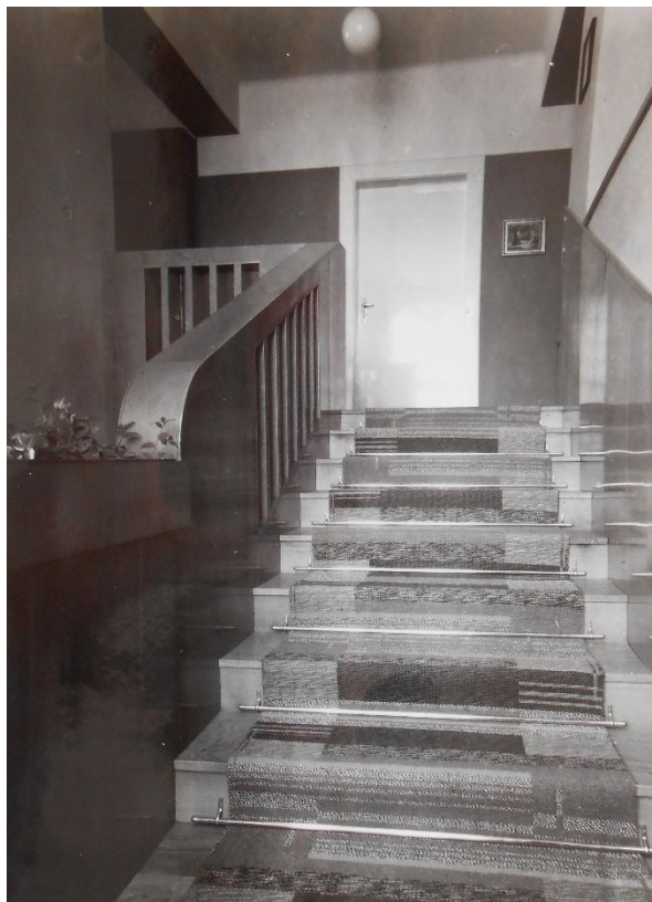
77. Šišma, rodinný dům paní Františky Vaškové, dobová fotografie interiéru, po 1932; Foto: archiv MUO
