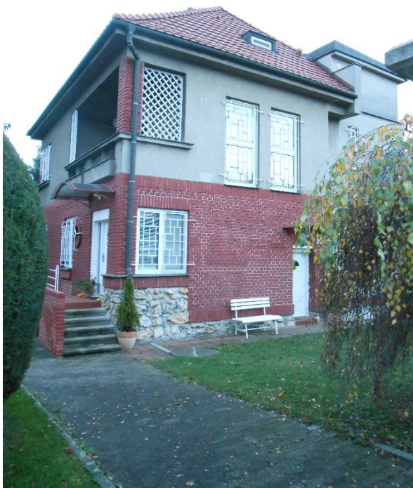
65. Předmostí u Přerova, rodinný dům Josefa Knejzlíka (ul. Tylova 20), současný stav 2013 – 2018; fotografie autorky
