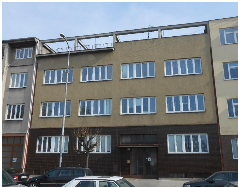
118. Přerov, dům manželů Lacinových, současný stav 2018; fotografie autorky
