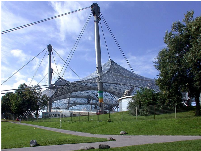
Obrázek 1.14.: Zavěšená střešní konstrukce, Olympijský stadion Mnichov [22]
